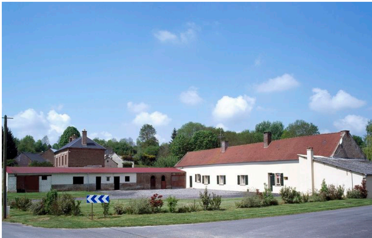
Vestiges restaurés de l'ancienne ferme, 33 rue de Berneuil, 2e moitié du 19e siècle.
