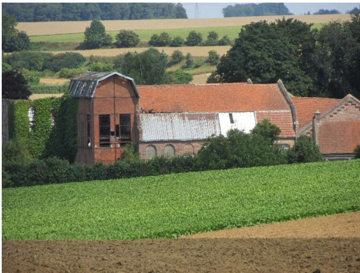
Vue d'ensemble sud.
