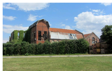
Vue d'ensemble sud de la râperie. Phot. Bertrand Fournier IVR22_20158006082NUCA
