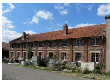
Vue de la façade sud-est des ateliers. Phot. Bertrand Fournier IVR22_20158006089NUCA
