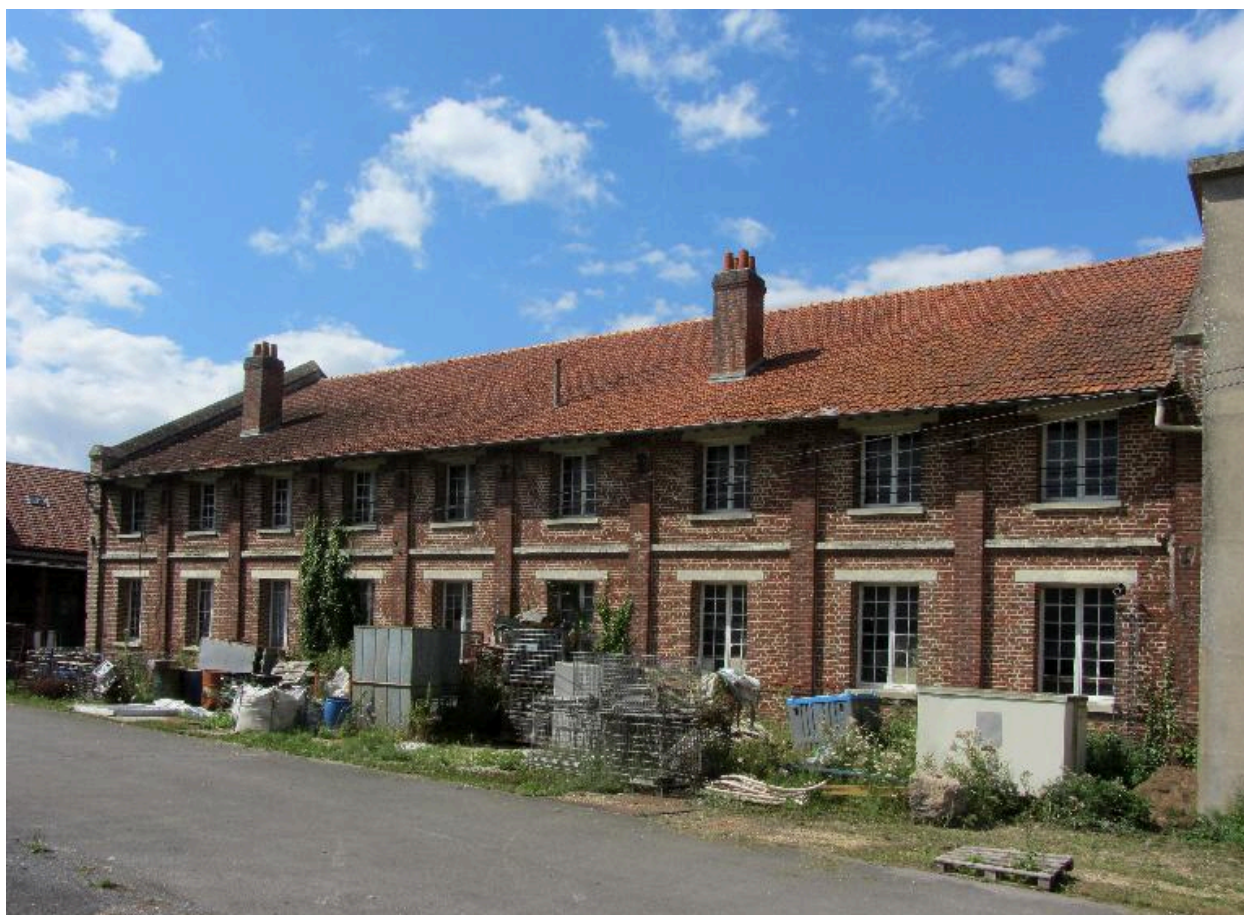
Vue de la façade sud-est des ateliers.
