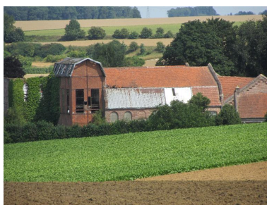
Vue d'ensemble sud. Phot. Bertrand Fournier IVR22_20158006065NUCA
