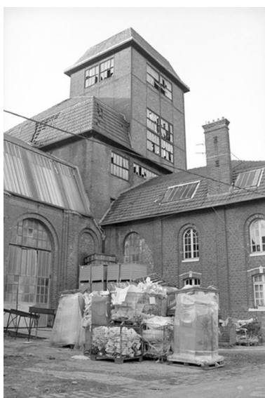
Atelier principal, flanc nord est, en 1990. Phot. Francis Dubuc IVR22_19908001348Z
