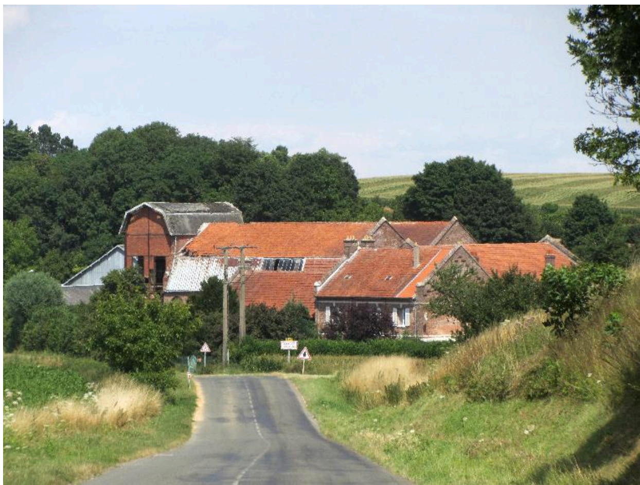
Vue d'ensemble sud-est.
