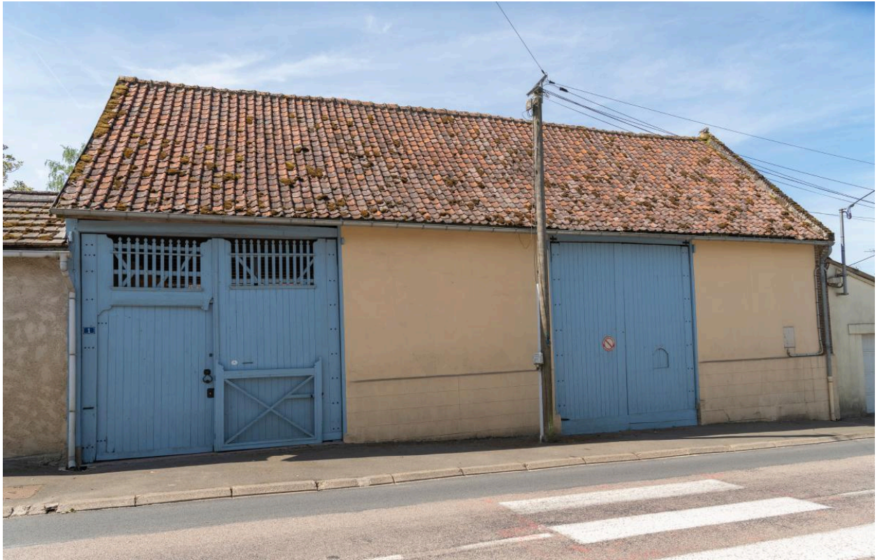
Ancienne grange sur rue avec entrée charretière, n°1 rue Notre-Dame, vue depuis le nord.
