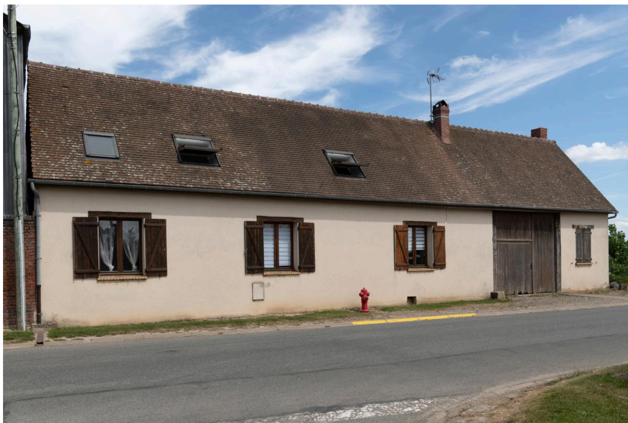
Logis sur rue avec entrée charretière, n°17 rue Tassart, vue depuis le sud-ouest.
