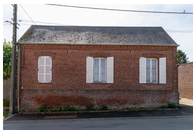
Logis sur rue en rez-de-chaussée surélevé, n°12 rue de la Ville, vue depuis le nord-est. Phot. Marc Kérignard IVR32_20226000382NUCA
