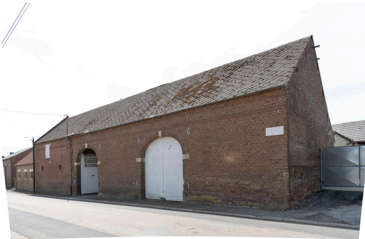
Grange et étable sur rue avec entrée charretière, porte la date de 1866, n°23 rue Notre-Dame, vue depuis le nord-ouest.
