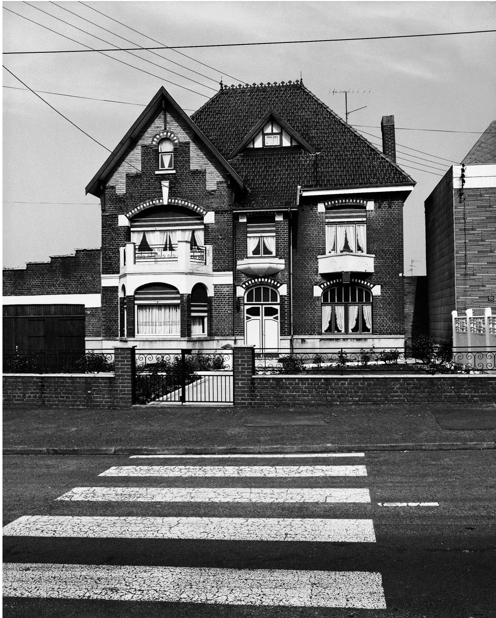
Vue générale de l'élévation antérieure.
