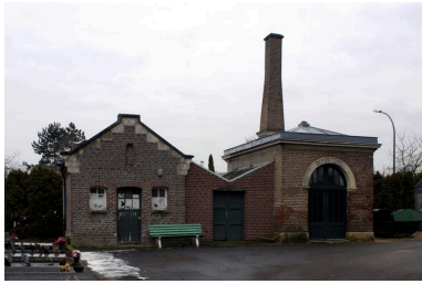
Dépotoire. Phot. Thierry Lefébure IVR22_20058000373NUCA
