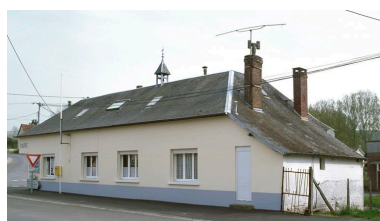
Vue générale depuis le nord-ouest. Phot. Marie-Laure Monnehay-Vulliet IVR22_20118000530XA
