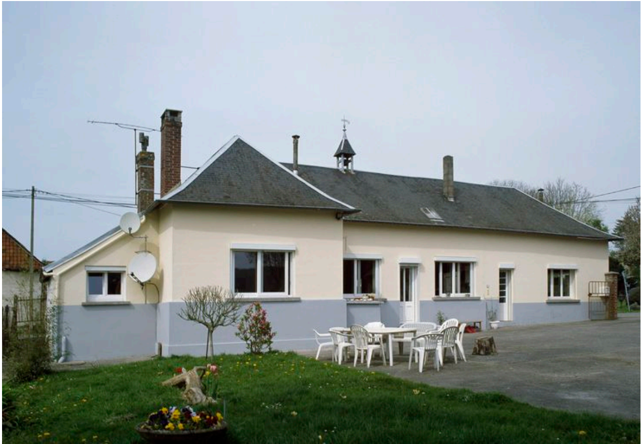
Elévation sur cour.
