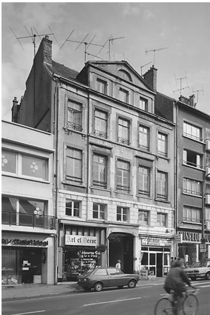
Vue générale d'angle sur voie.
