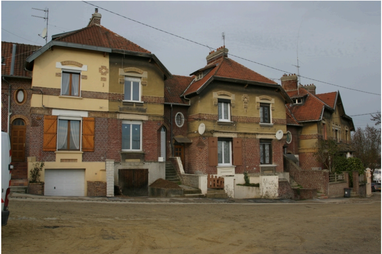
Deux bâtiments à deux logements (à gauche).
