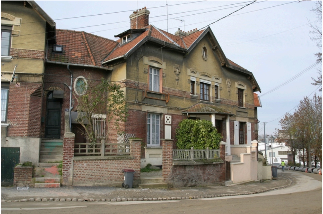
Façade antérieure d'un bâtiment à trois logements.
