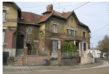
Façade antérieure d'un bâtiment à trois logements. Phot. Frédéric Pillet IVR22_20070205074NUCA
