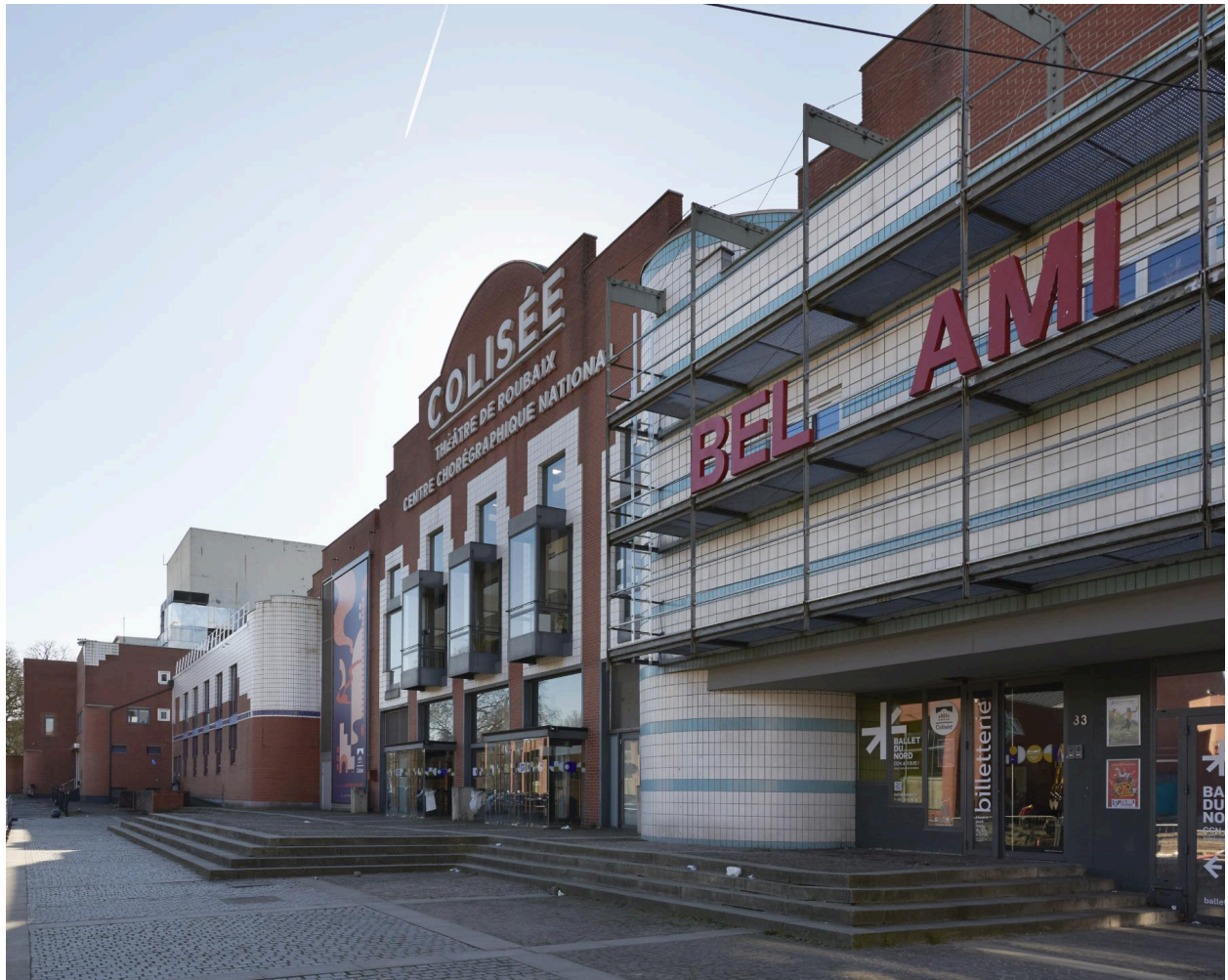
Façade nord vue en enfilade.
