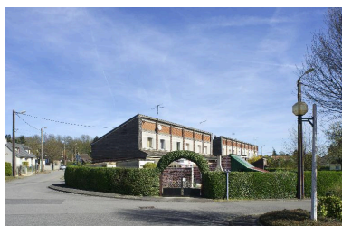
Maisons à plusieurs unités d'habitation. (rue de la Famille-Boure). Vue de situation depuis la rue du Paradis.
