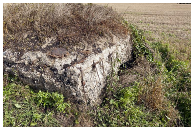
Vue vers le nord Phot. Jean-Marc Ramette IVR31_20145904155NUCA
