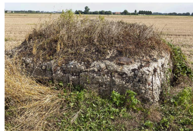
Vue vers le nord Phot. Jean-Marc Ramette IVR31_20145904154NUCA
