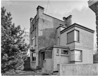
Élévation de trois quarts. Phot. Olivier Marlard IVR31_19935900210V
