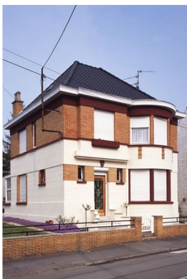
Une des maisons Bedart, rue Dupire. Phot. Pierre Thibaut IVR31_20085900364XA
