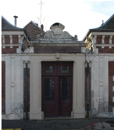
Le portail. Phot. Marie-Laure Monnehay-Vulliet IVR22_20158001035NUC2A
