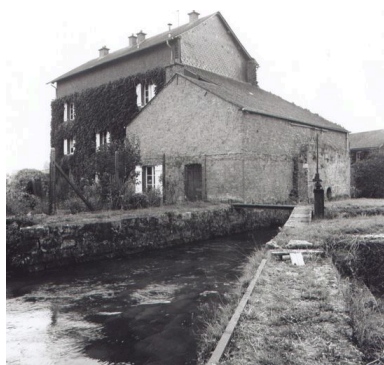
Vue d'ensemble postérieure.
