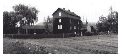
Vue d'ensemble de la minoterie de Monceaux. Phot. Thierry Lefébure IVR22_20026000701X
