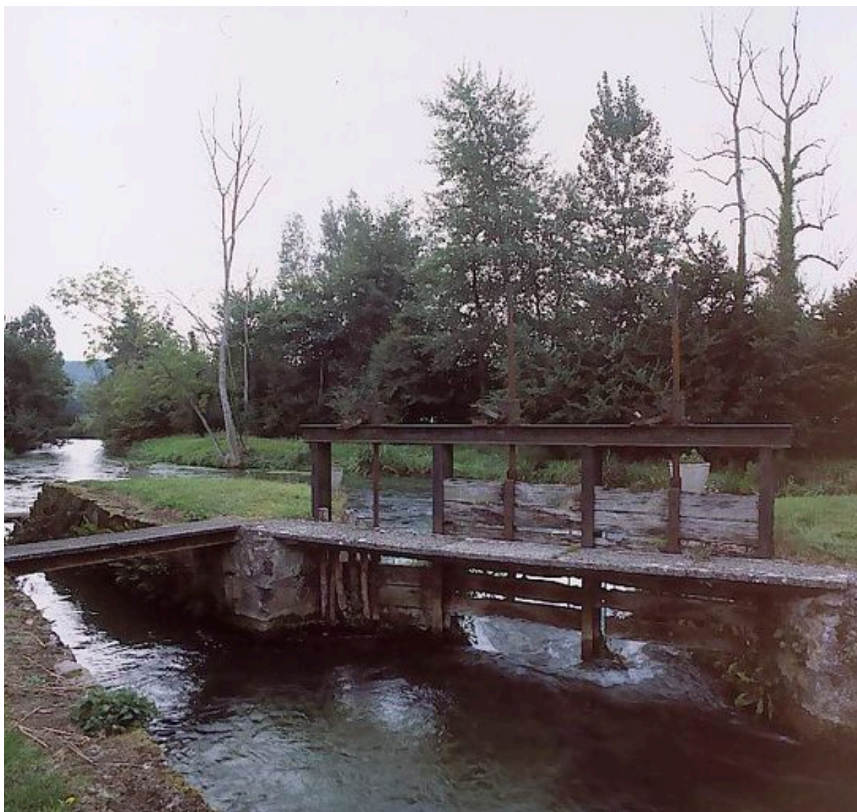
Le vannage de décharge.
