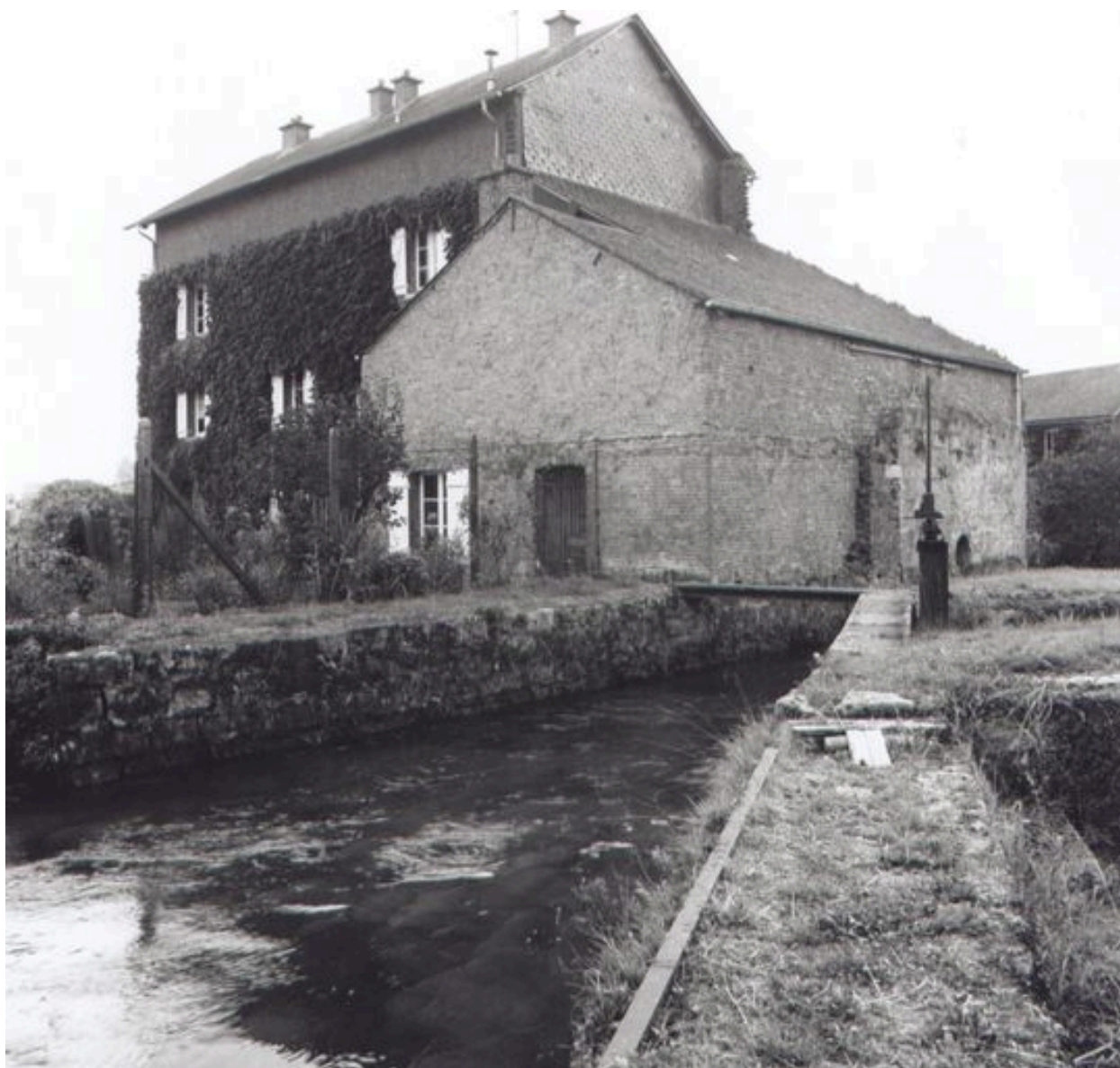
Vue d'ensemble postérieure.
