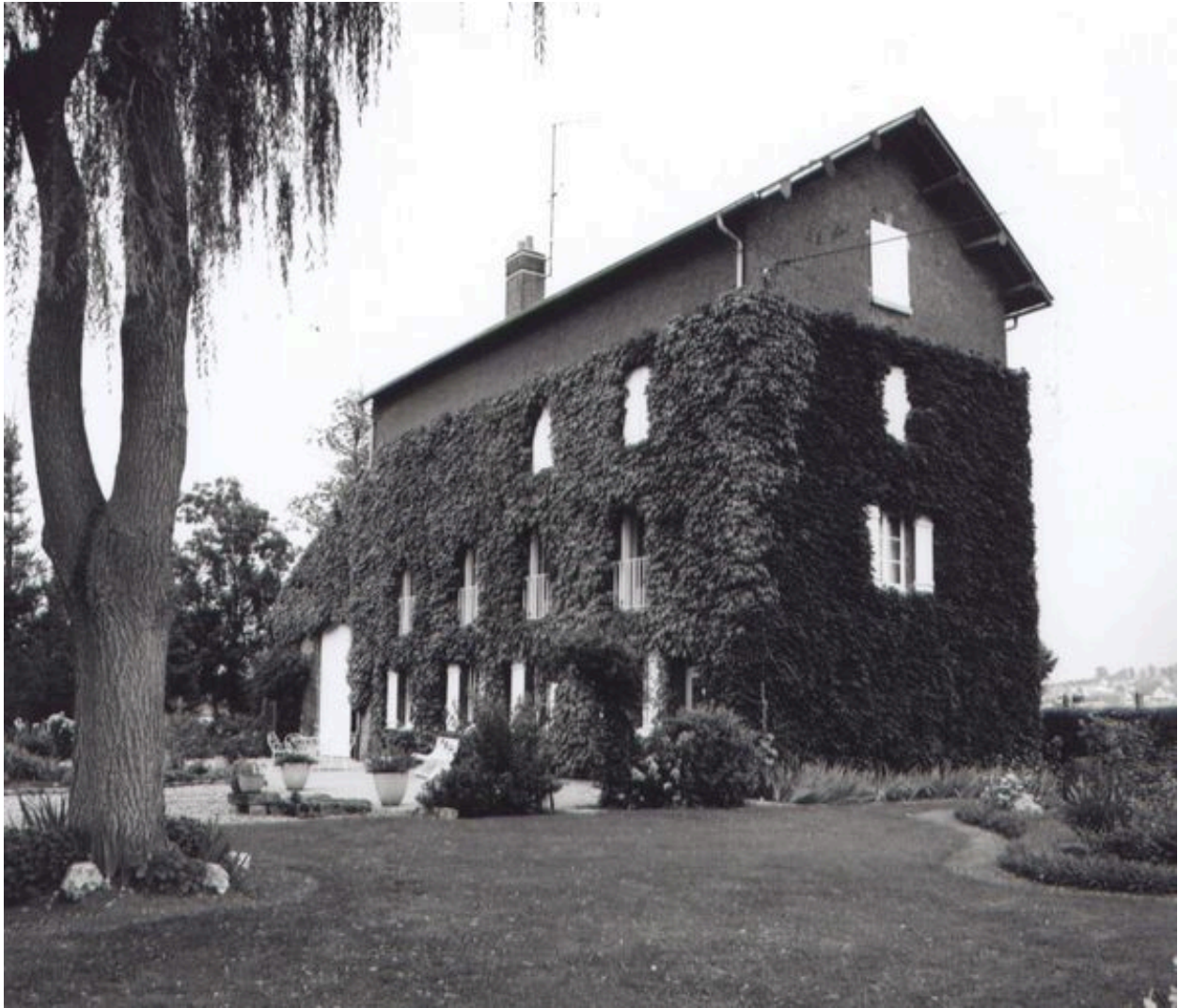
Vue d'ensemble sur cour du bâtiment de la minoterie.
