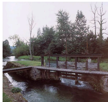
Le vannage de décharge. Phot. Thierry Lefébure IVR22_20026000946NUCA
