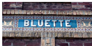
Détail des carreaux de céramique formant appellation. Phot. Elisabeth Justome IVR22_20048001498NUCA
