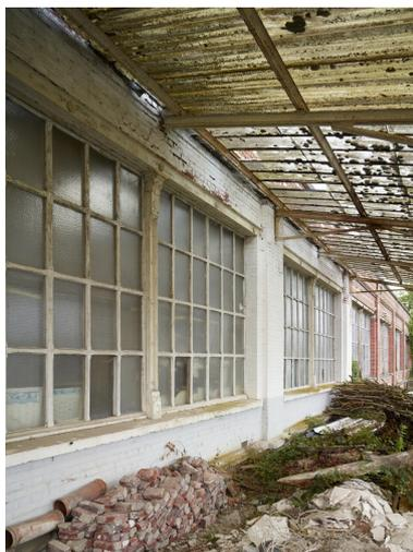
Baies de l'élévation antérieure de l'atelier de fabrication, détail d'un meneau métallique.
