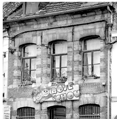
Façade, vue partielle : étage. Phot. Pierre Thibaut IVR31_20055900864X
