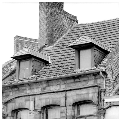
Façade, vue partielle : étage de comble, lucarnes, toiture. Phot. Pierre Thibaut IVR31_20055900872X
