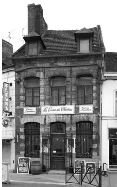
Vue générale (état en 2001). Phot. Pierre Thibaut IVR31_20015901137X
