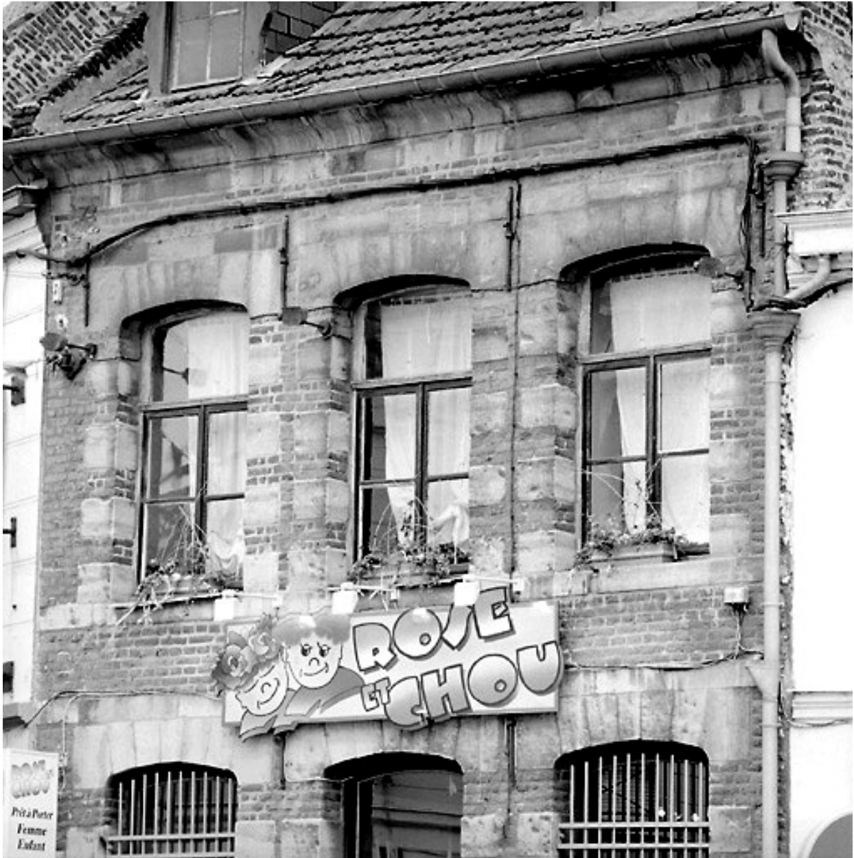
Façade, vue partielle : étage.
