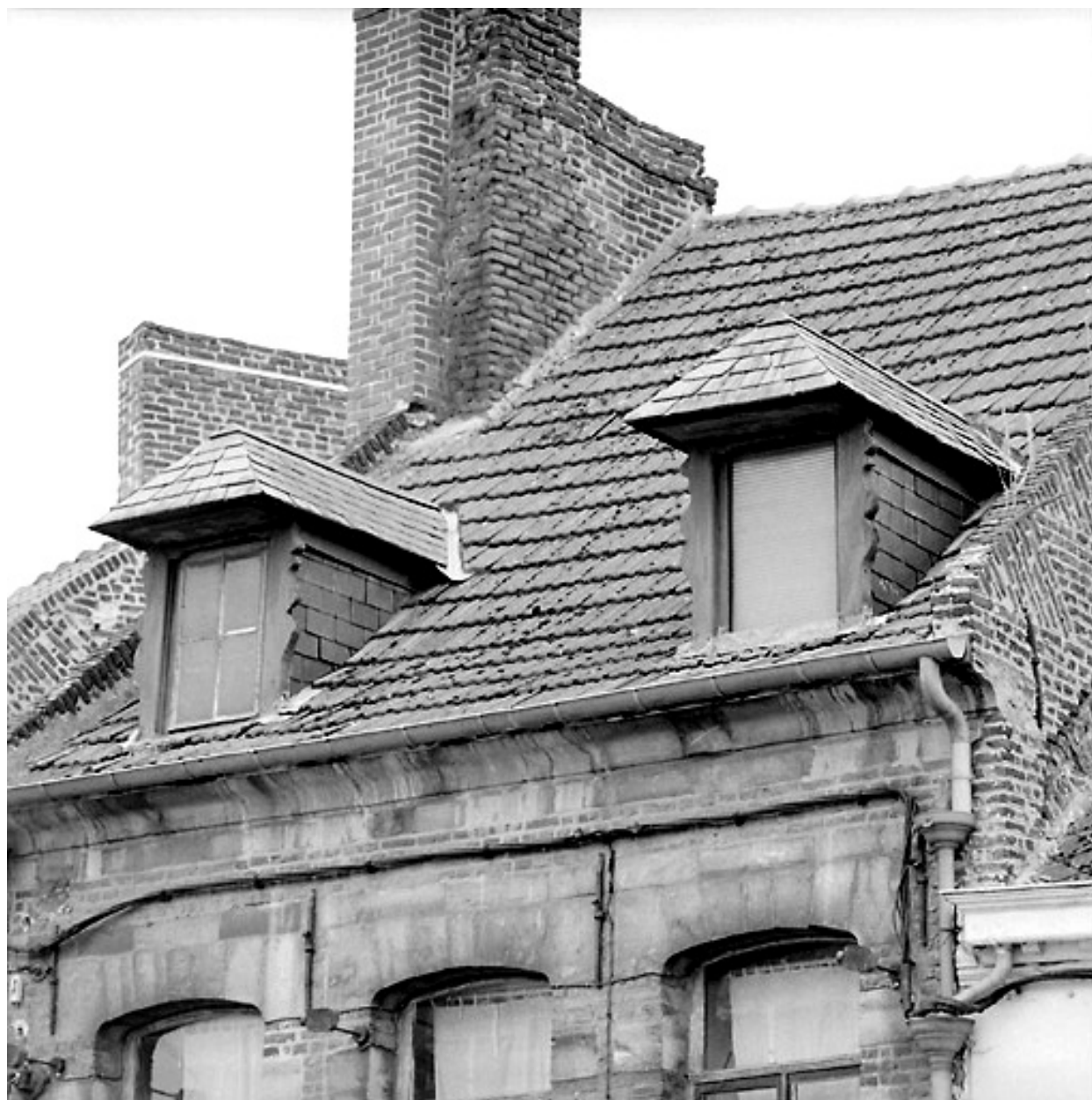
Façade, vue partielle : étage de comble, lucarnes, toiture.
