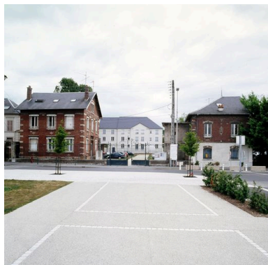
Pavillons d'accueil des anciens entrepôts de vins Lesage à Nogent-sur-Oise. Phot. Thierry Lefébure IVR22_20076000036XA
