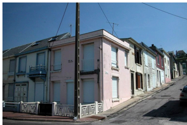
Vue d'ensemble sur l'angle, depuis la place Clémenceau, vers la rue Continental.
