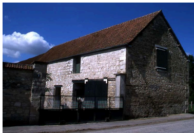
Vue de la grange. Phot. Inès Guérin IVR22_20030203244NUCA
