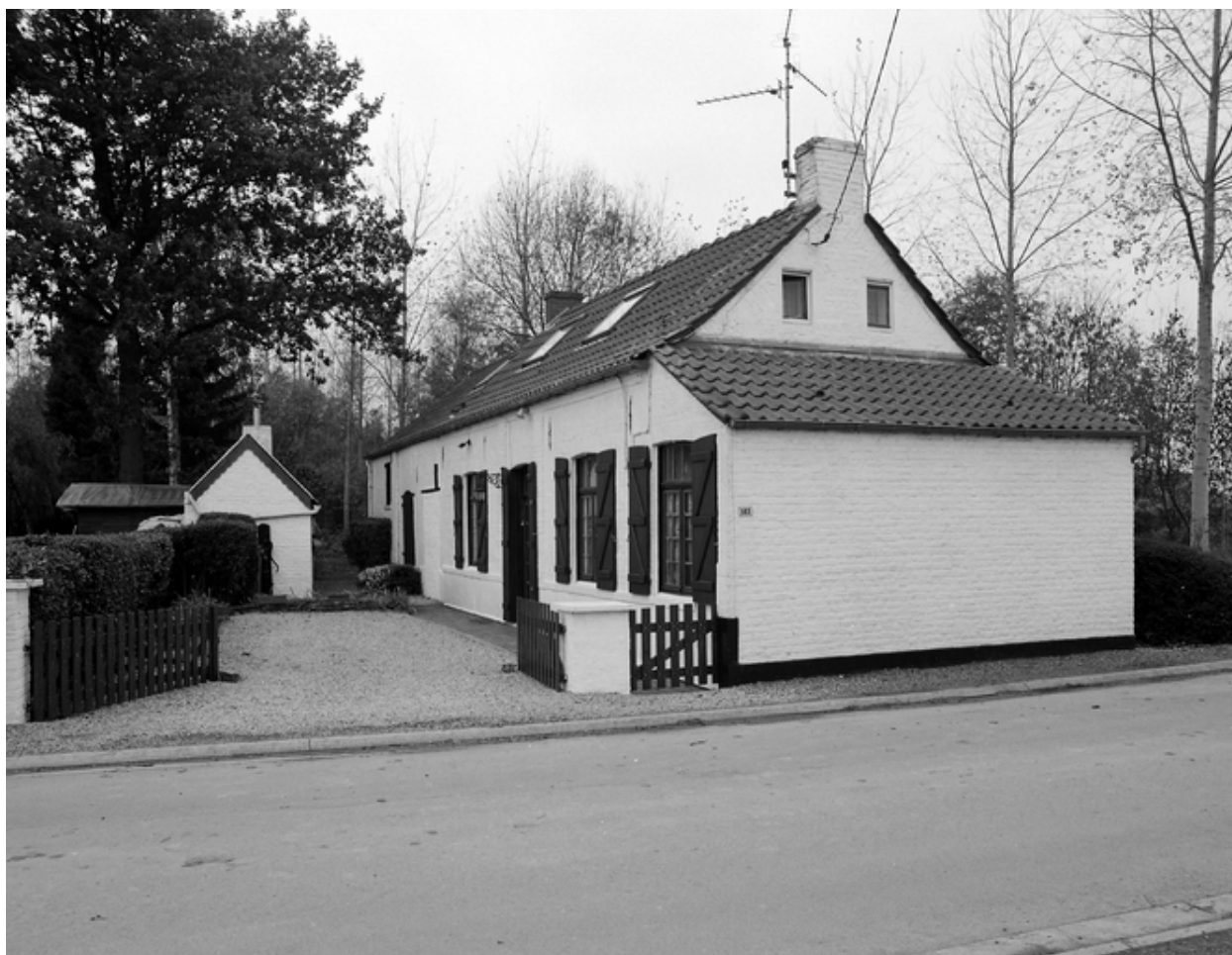
Ferme élémentaire, 583, rue Prière, logis et fournil.
