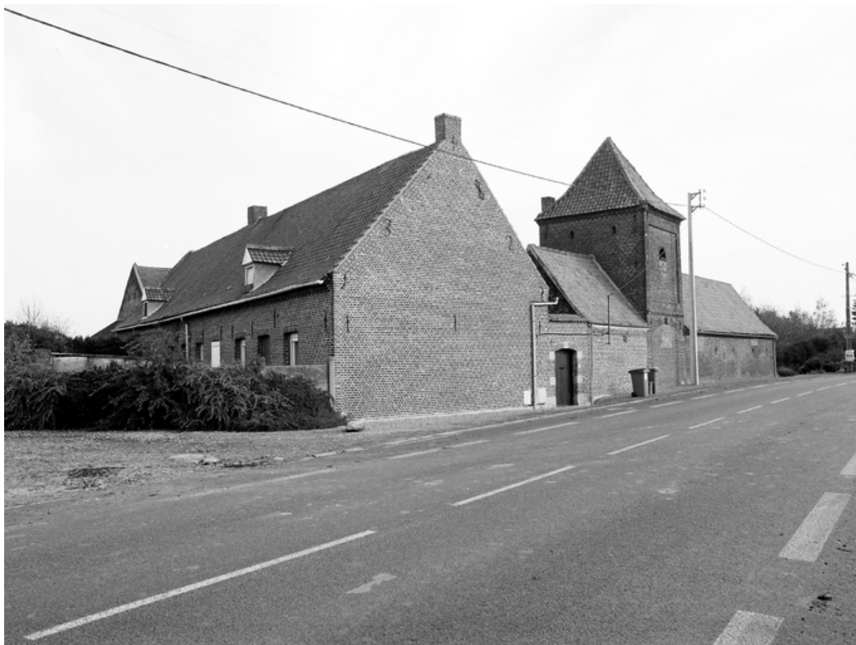
Ferme, 443, rue du Grand Chemin, vue générale.
