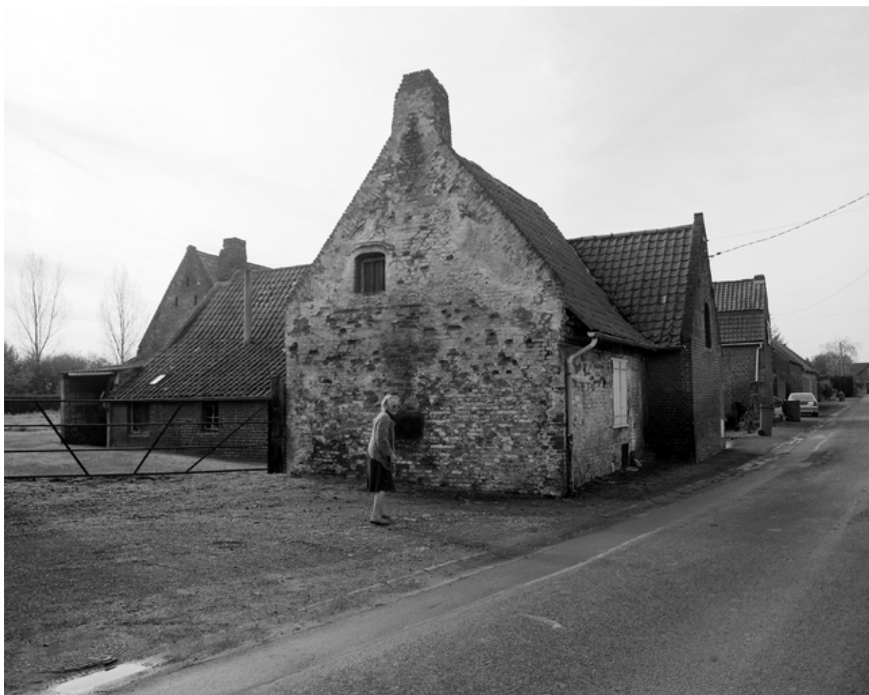
137, rue de la Caisse, pignon.
