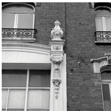
Élévation antérieure. Travée centrale. Amortissement en pierre. Phot. Philippe Dapvril IVR31_19885900823X
