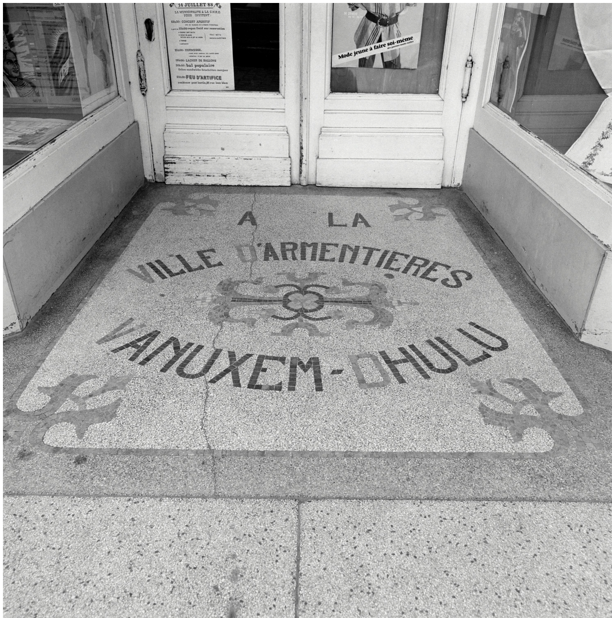
Pavage en mosaïque de l'entrée de la boutique.
