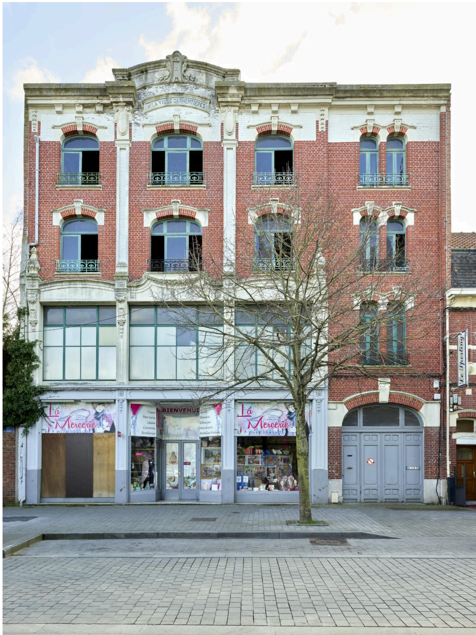
Élévation antérieure en 2023.
