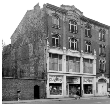
Vue de trois quarts prise vers le sud-ouest. Phot. Philippe Dapvril IVR31_19885900821X
