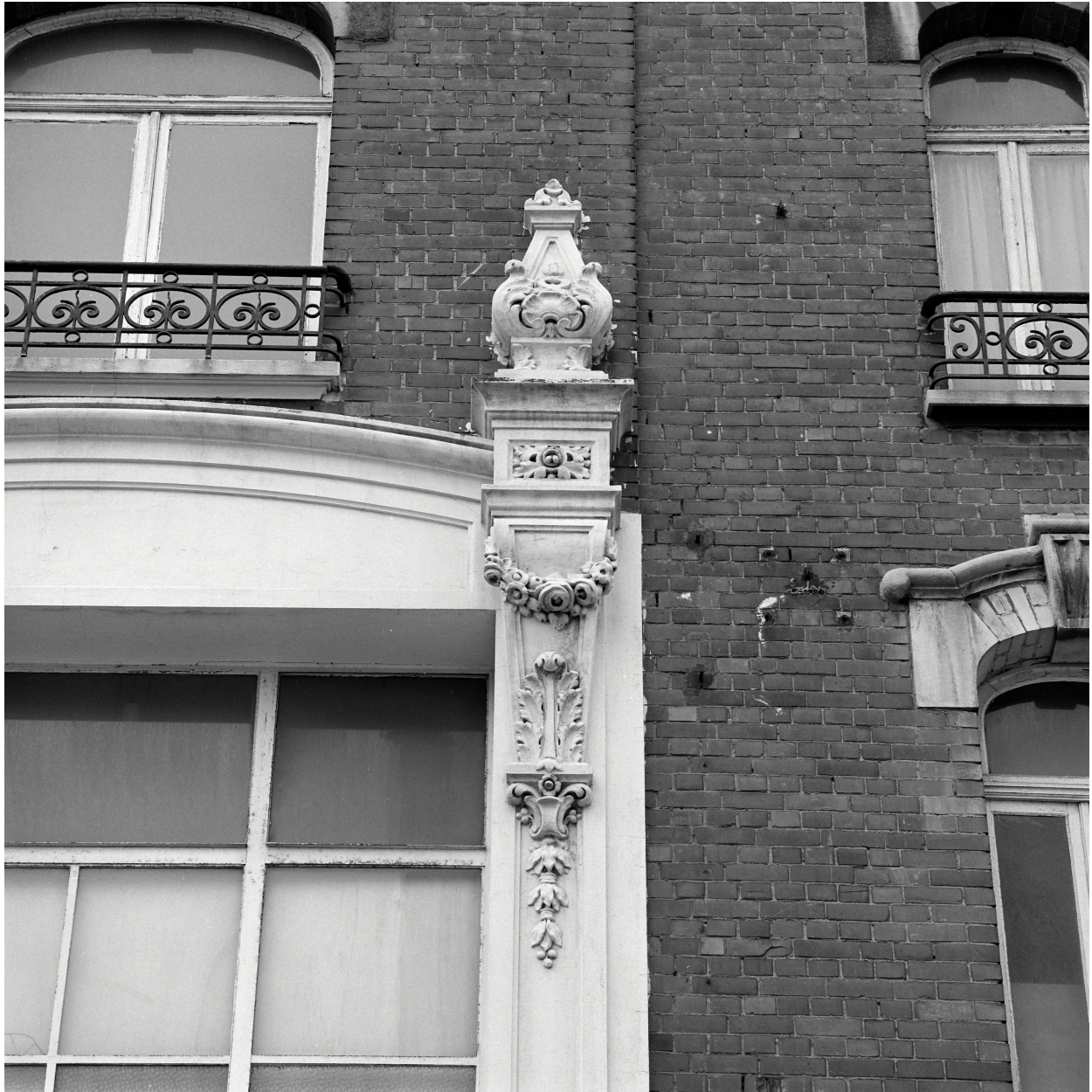
Élévation antérieure. Travée centrale. Amortissement en pierre.
