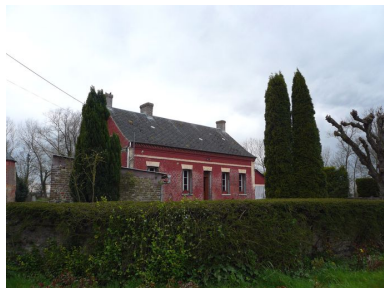
Vue du logis depuis la cour. Phot. Inès Guérin IVR22_20078005725NUCA
