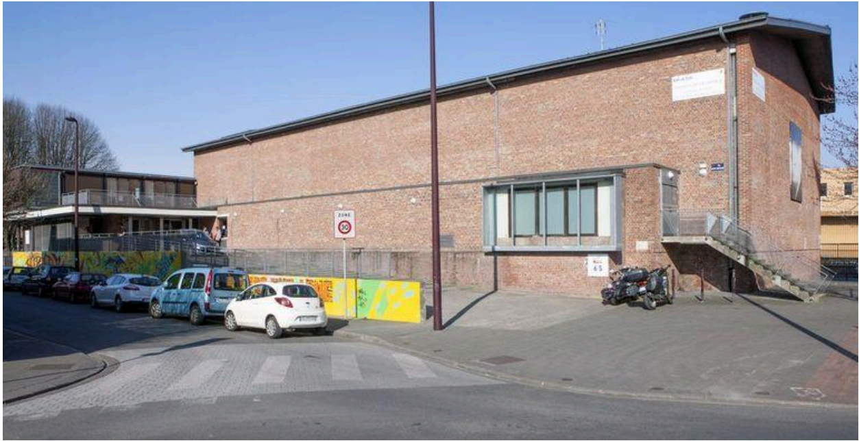
Élévation du flanc gauche, avec entrée.
