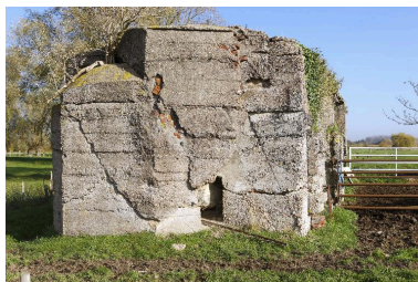
Pignon ouest Phot. Jean-Marc Ramette IVR31_20145904875NUCA
