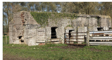
Vue de trois-quarts vers le nord-est Phot. Jean-Marc Ramette IVR31_20145904874NUCA
