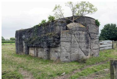
Vue latérale, vers le sud-est Phot. Pierre Thibaut IVR31_20155901456NUCA
