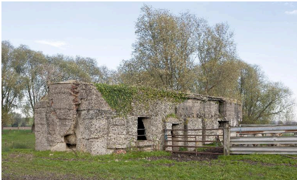
Vue de trois-quarts vers le nord-est
