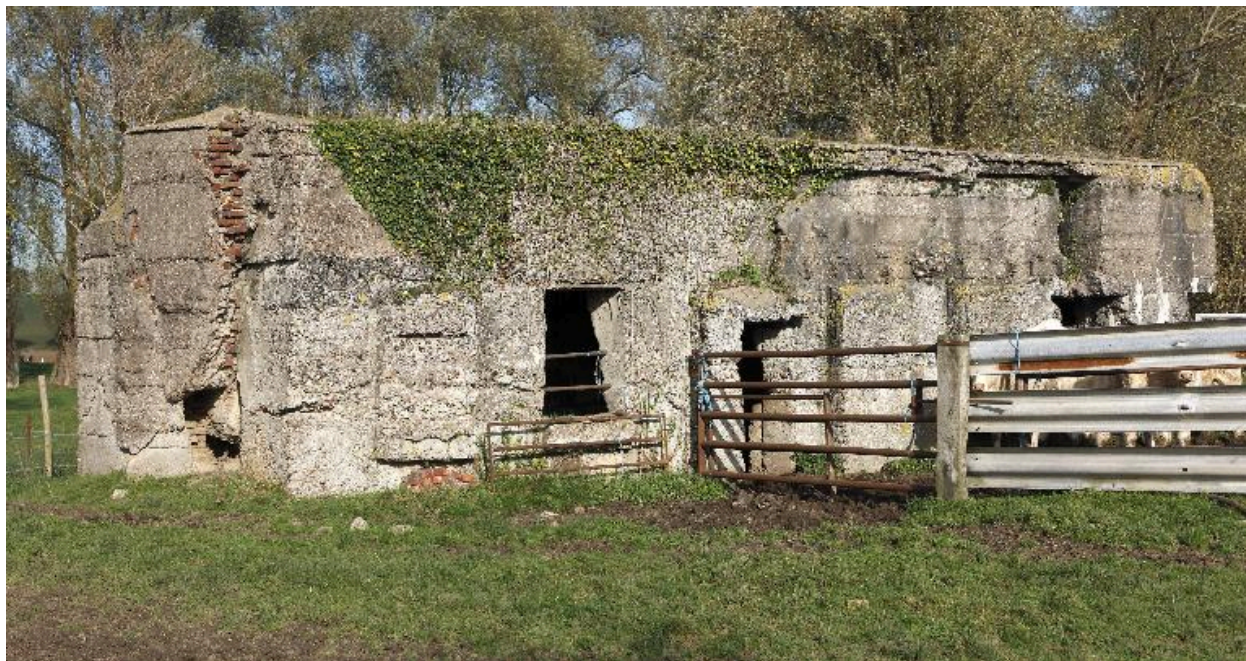
Vue de trois-quarts vers le nord-est
