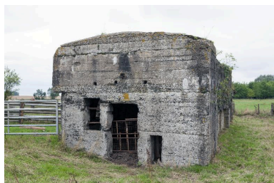
Pignon ouest Phot. Pierre Thibaut IVR31_20155901459NUCA
