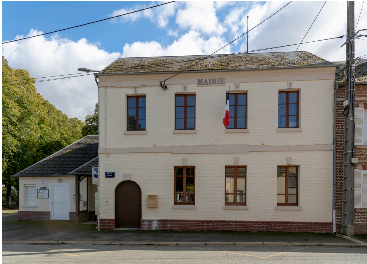
Mairie, bâtiment construit en 1851, n°8 place des Déportés, vue depuis le nord.
