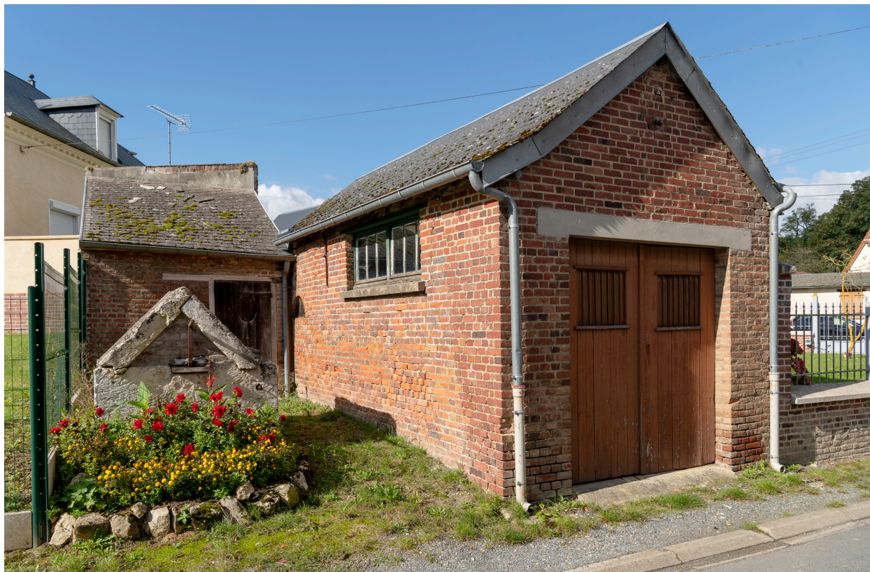
Ancienne remise des pompes à incendie, rue Fernand-Moreau, vue depuis le sud.
