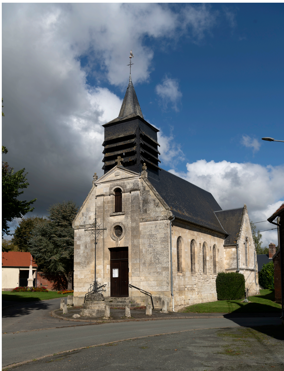
Église Saint-Martin, vue depuis l'ouest.
