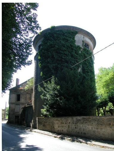
Vue du silo.
