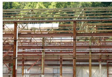
Détail de la charpente métallique. Phot. Clarisse Lorieux IVR22_20086005056NUCA
