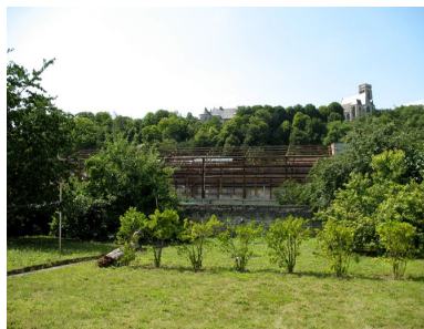
Les ateliers en cours de démolition en juillet 2007, vus vers le nord. Phot. Clarisse Lorieux IVR22_20086005054NUCA
