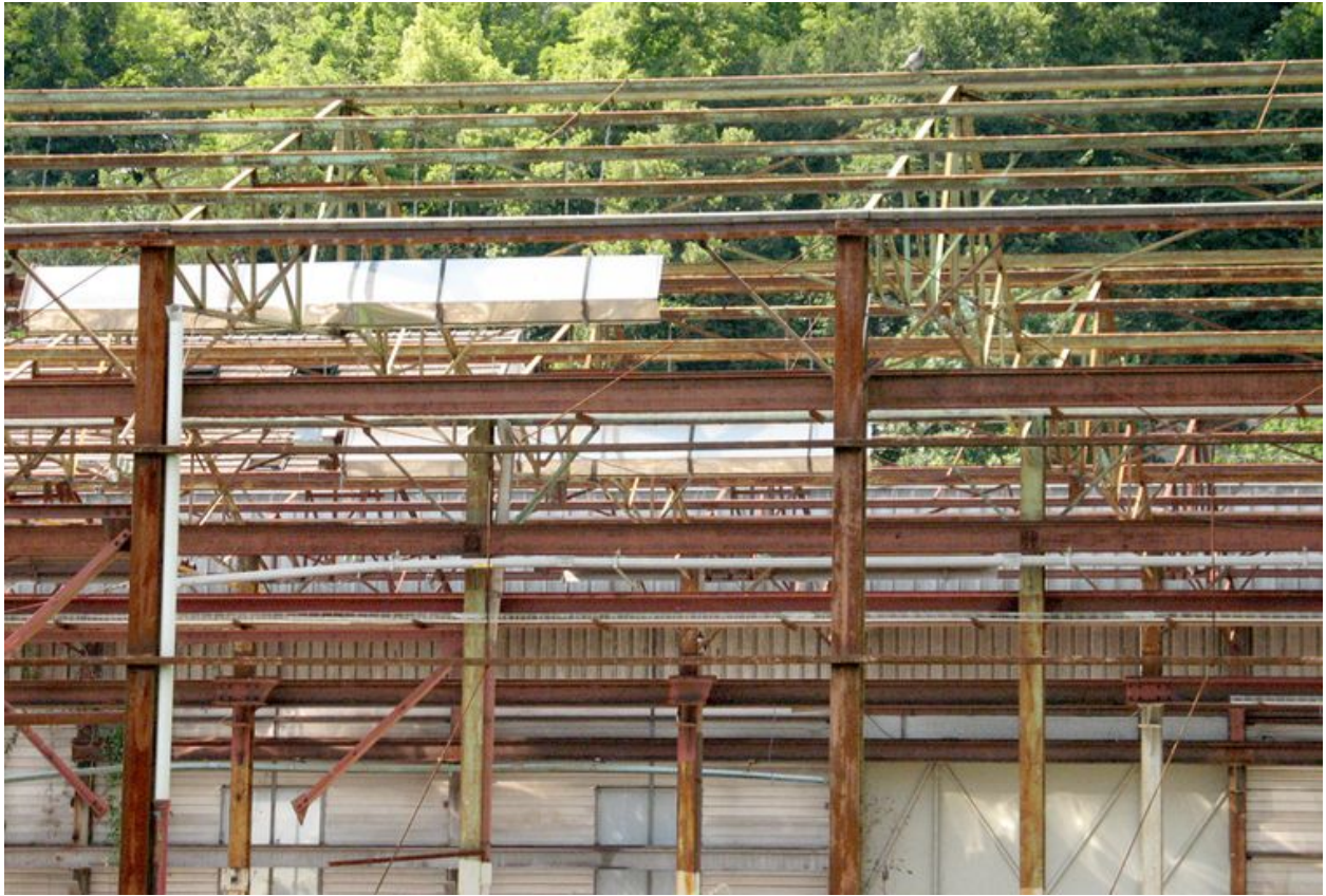
Détail de la charpente métallique.
