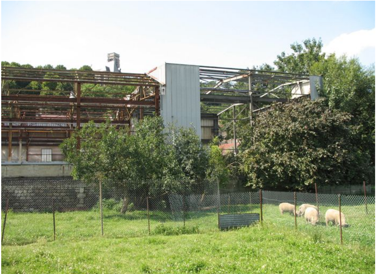
Détail des derniers bardages des ateliers.
