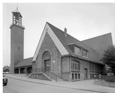
Vue d'angle sud sur rue de la Libération. Phot. Philippe Dapvril IVR31_19966200796V
