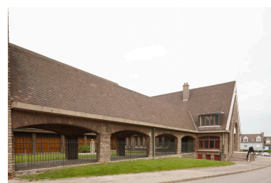
Vue des galeries et de la chapelle de semaine. Phot. Hubert Bouvet IVR31_20106200728NUC4A
