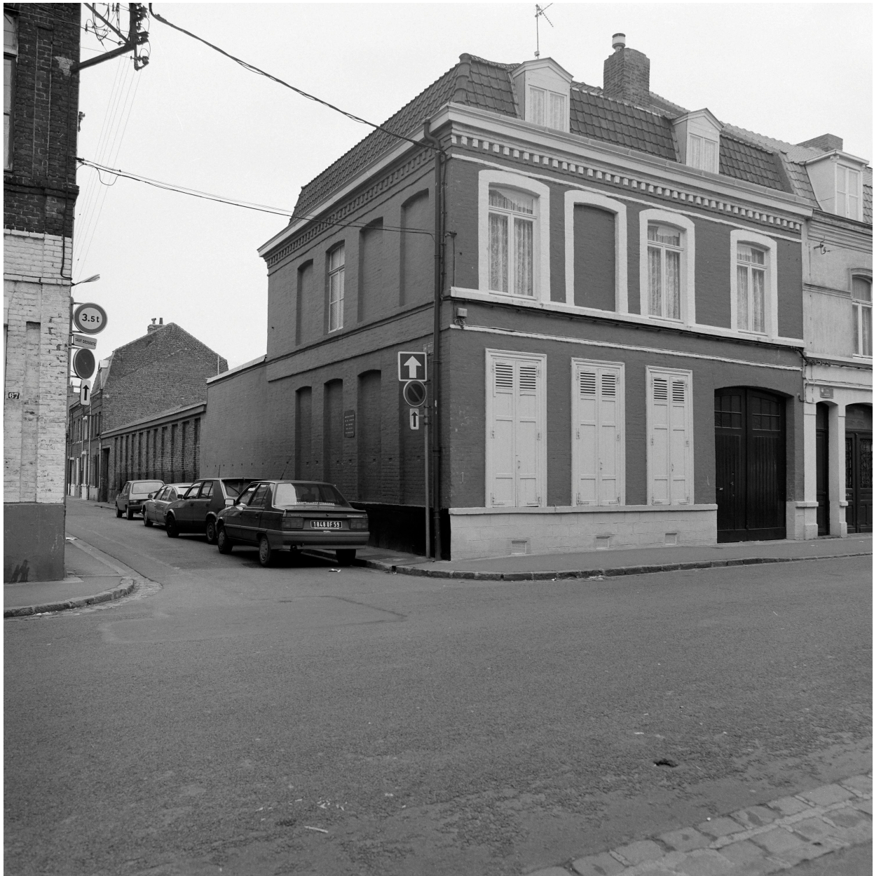
Logement patronal et atelier de fabrication vers l'est.
