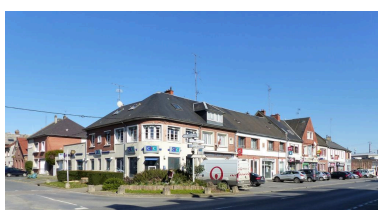
Vue du groupe est, boulevard Gambetta, depuis le carrefour de l'avenue du Général-De Gaulle. Phot. Isabelle Barbedor IVR32_20220205075NUCA
