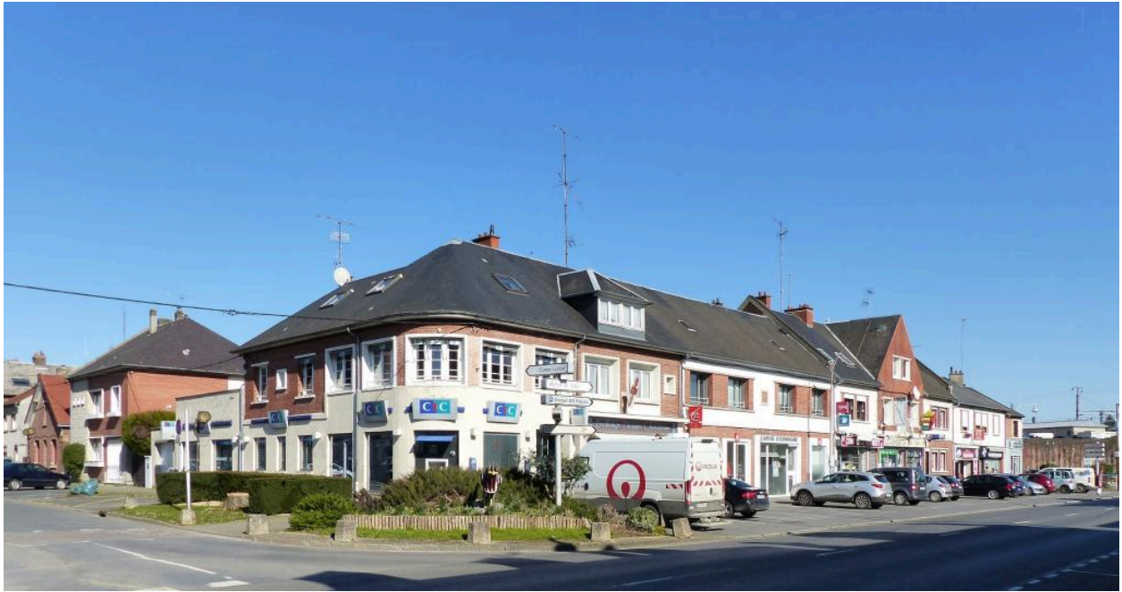
Vue du groupe est, boulevard Gambetta, depuis le carrefour de l'avenue du Général-De Gaulle.
