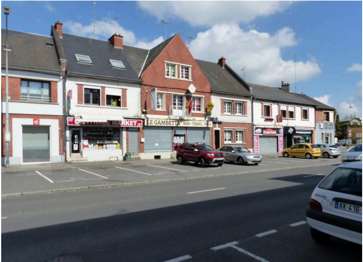
Boulevard Gambetta. Vue du groupe est, 2 à 8 boulevard Gambetta.
