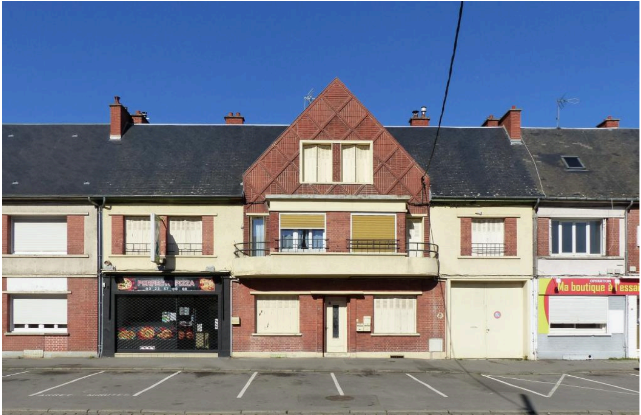
Partie centrale du groupe ouest, 20 à 32 boulevard Gambetta.
