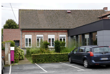
Vue partielle de la façade nord. Phot. Delphine Volto Jourdan IVR32_20245902947NUCA
