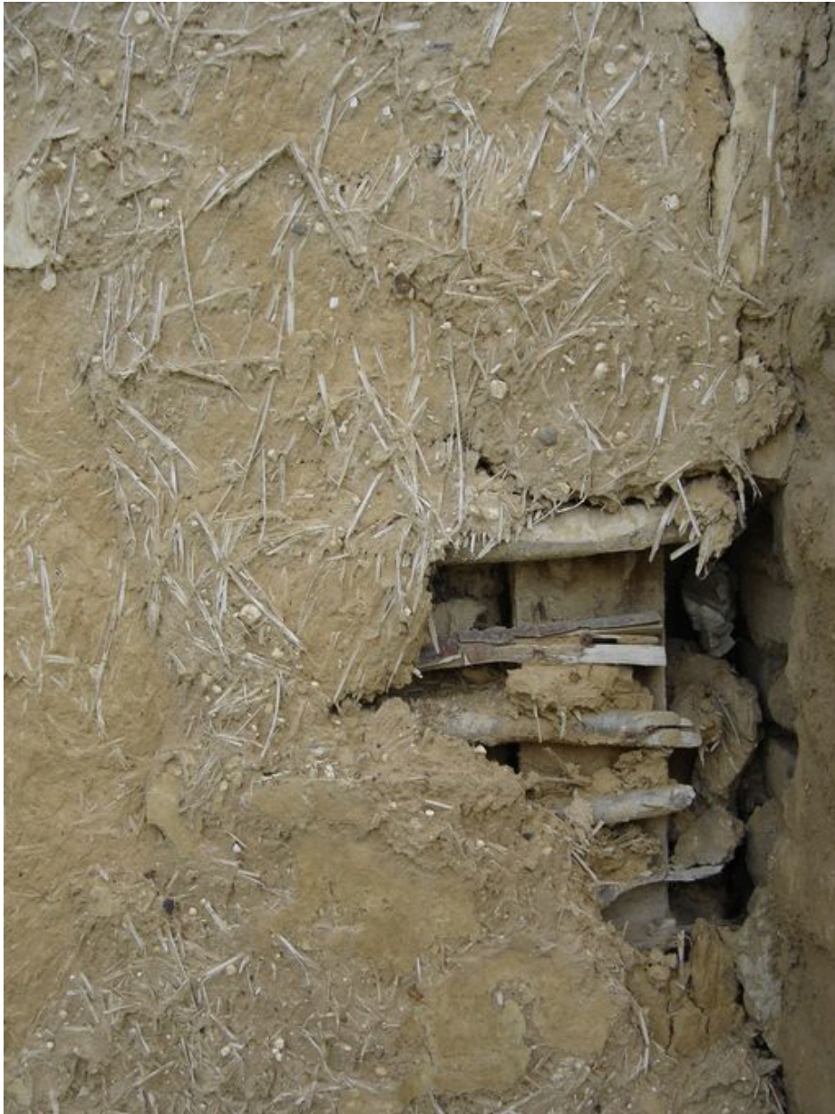
Vue détaillée de la maçonnerie en torchis et pans de bois.
