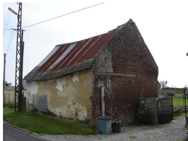
Vue latérale. Phot. Inès Guérin IVR22_20078005213NUCA
