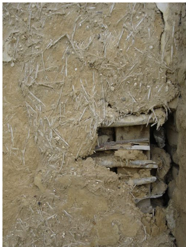
Vue détaillée de la maçonnerie en torchis et pans de bois. Phot. Inès Guérin IVR22_20078005214NUCA
