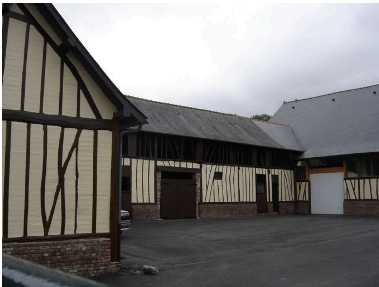
Vue des étables depuis la cour.
