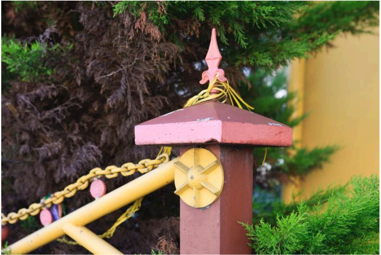
Façade sur rue, détail de la clôture.
