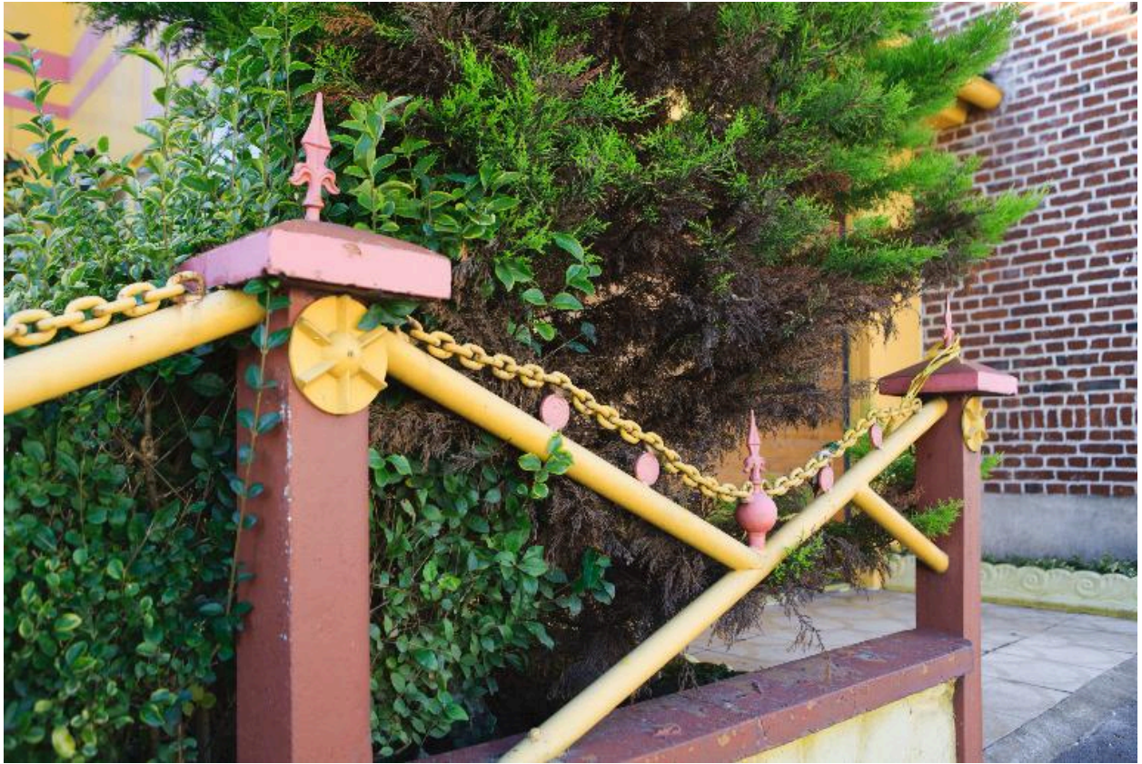
Façade sur rue, détail de la clôture.
