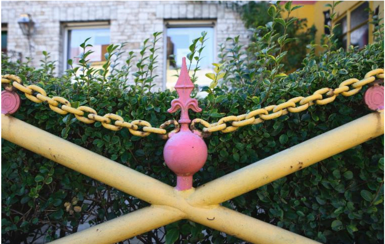
Façade sur rue, détail de la clôture.
