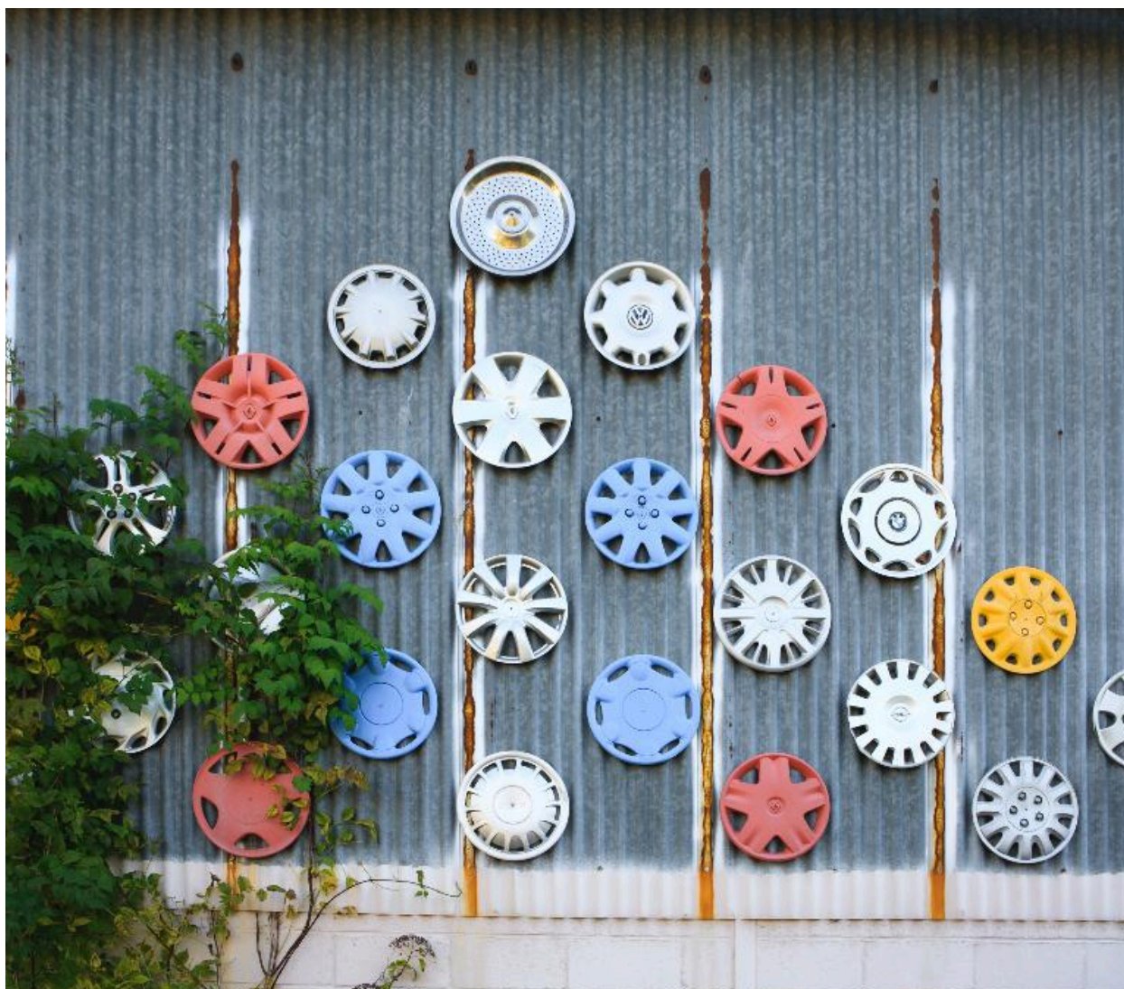
Enjoliveurs de roues d'automobiles apposés sur le mur gouttereau du bâtiment voisin.
