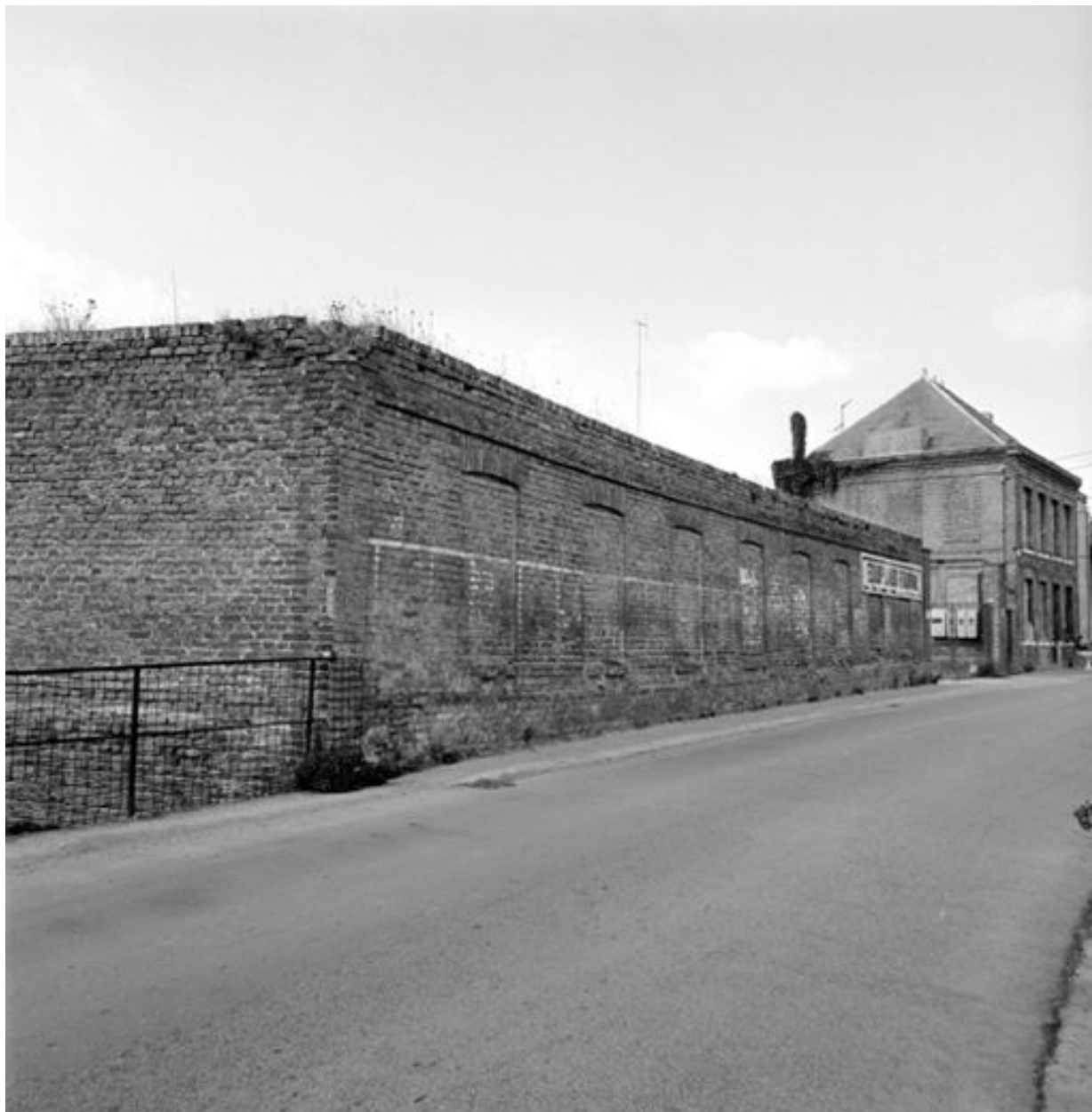
Atelier de fabrication, vestiges de l'élévation antérieure.
