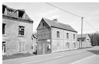
Conciergerie, élévation antérieure.
