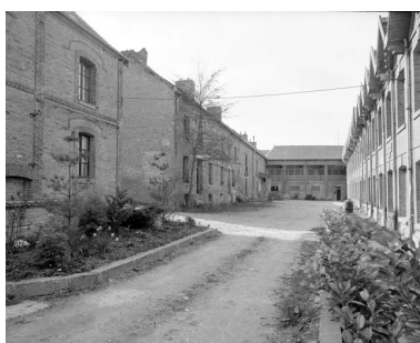
Cour, logements ouvriers et ateliers de fabrication.
