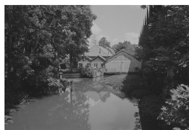
Bâtiment d'eau, flanc amont.
