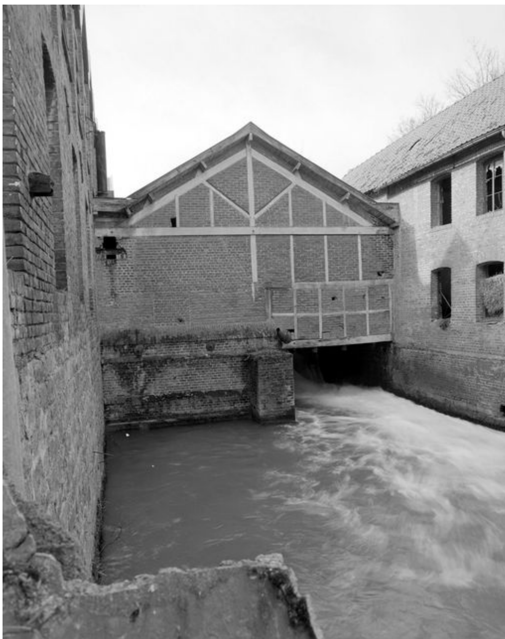
Bâtiment d'eau, flanc aval.
