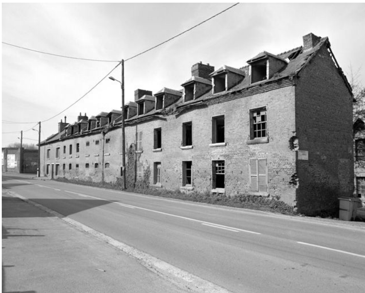
Logements ouvriers, élévation antérieure.
