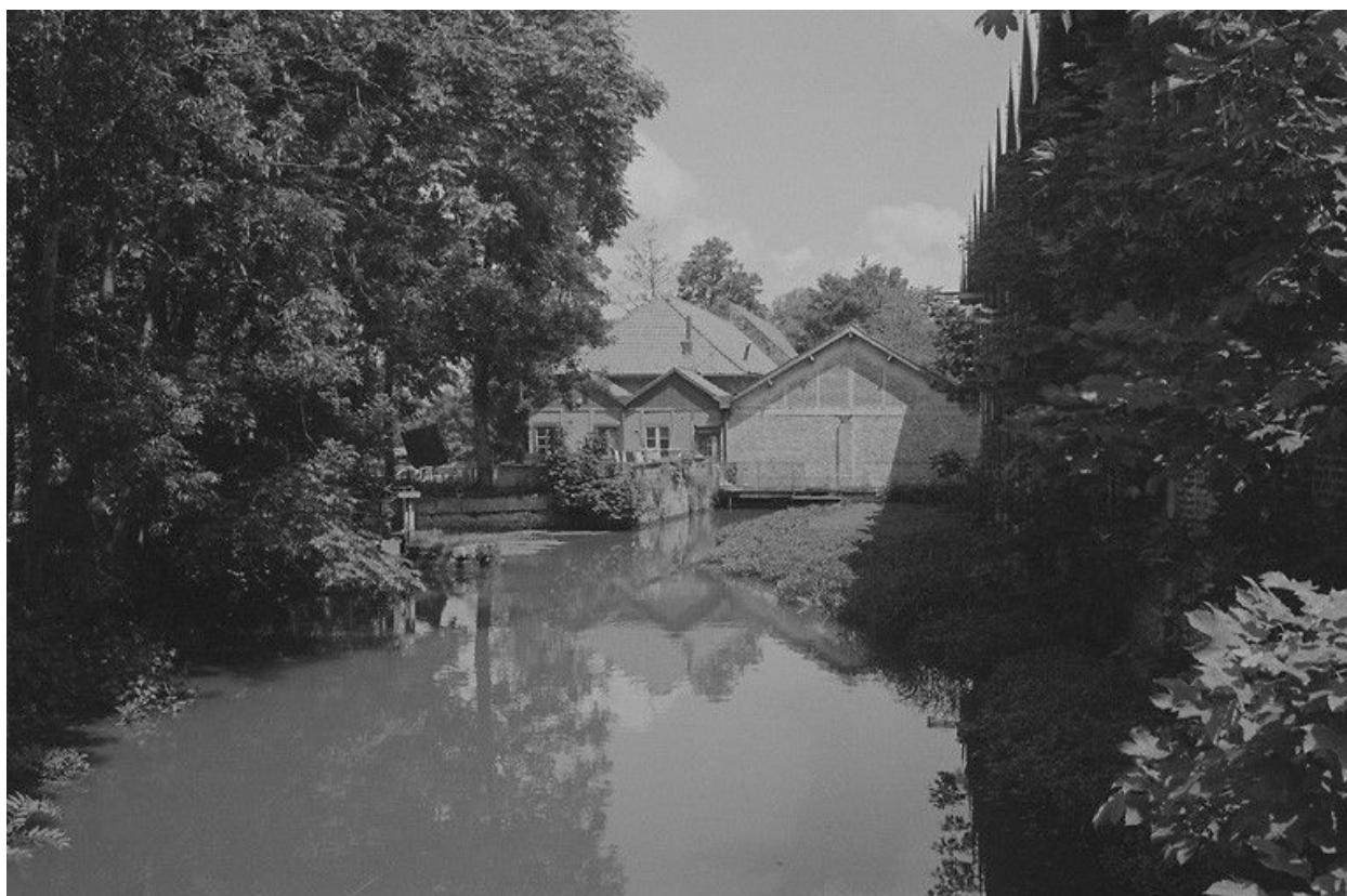
Bâtiment d'eau, flanc amont.
