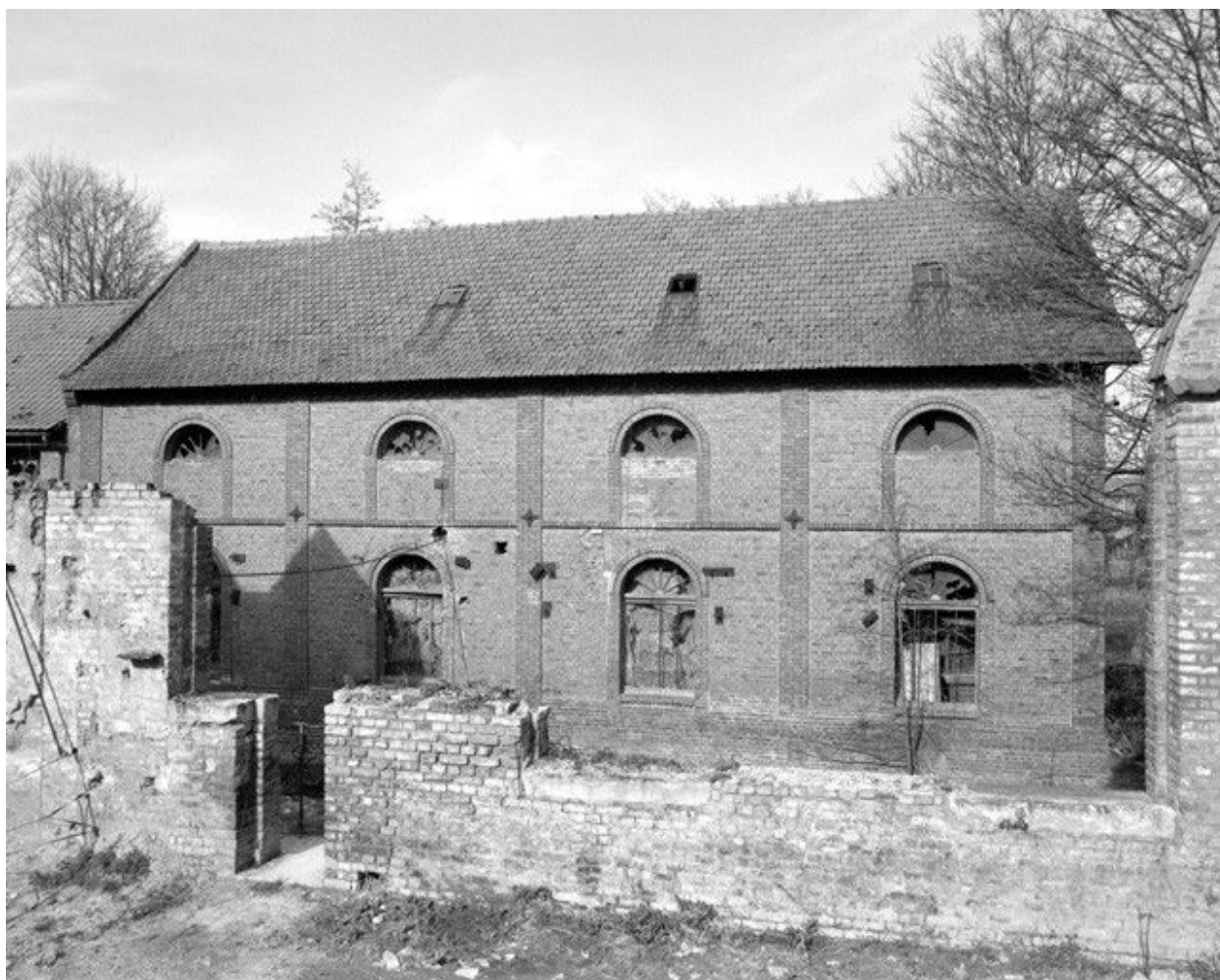
Ateliers de fabrication, flanc est.
