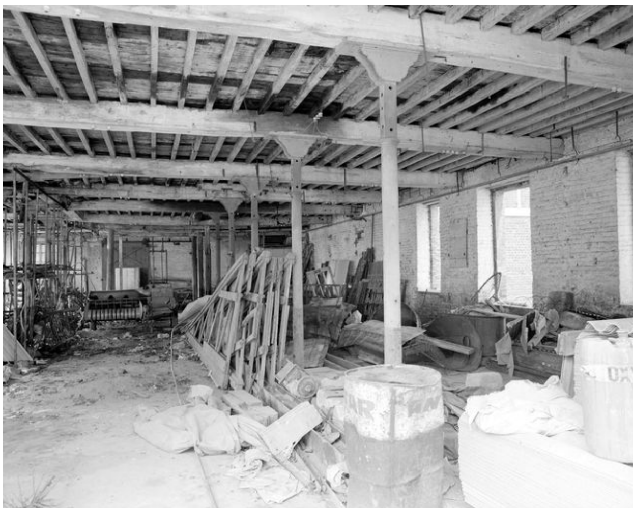
Ateliers de fabrication, rez-de-chaussée, vue intérieure.
