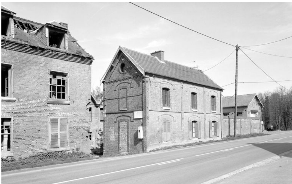
Conciergerie, élévation antérieure.
