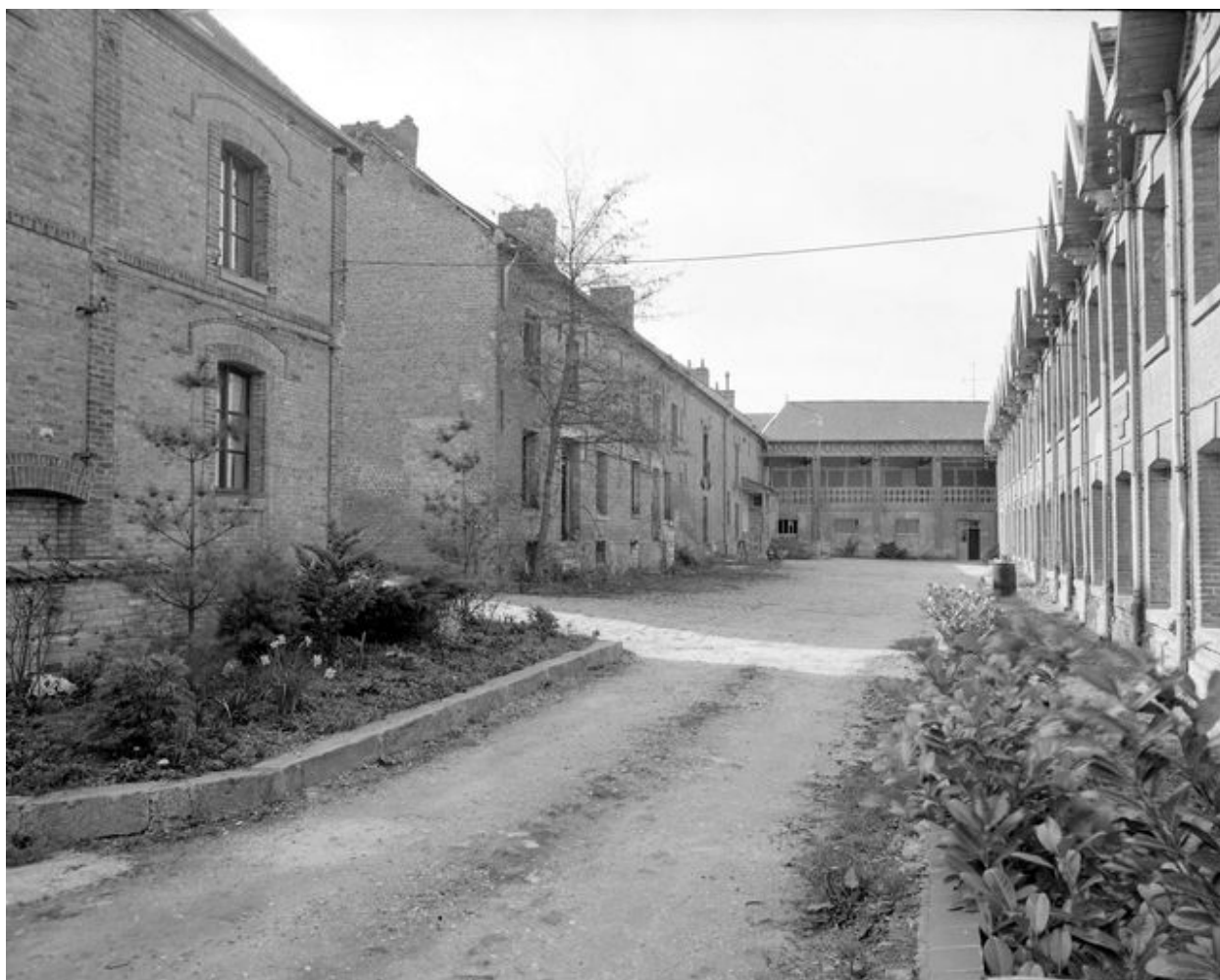
Cour, logements ouvriers et ateliers de fabrication.
