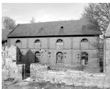
Ateliers de fabrication, flanc est.
