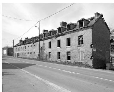
Logements ouvriers, élévation antérieure.
