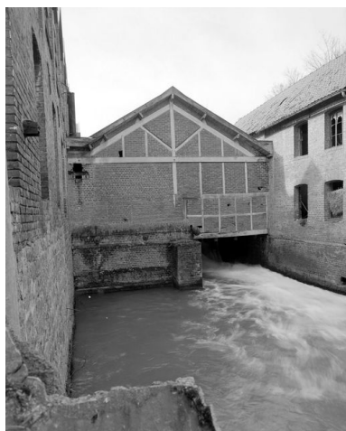
Bâtiment d'eau, flanc aval.
