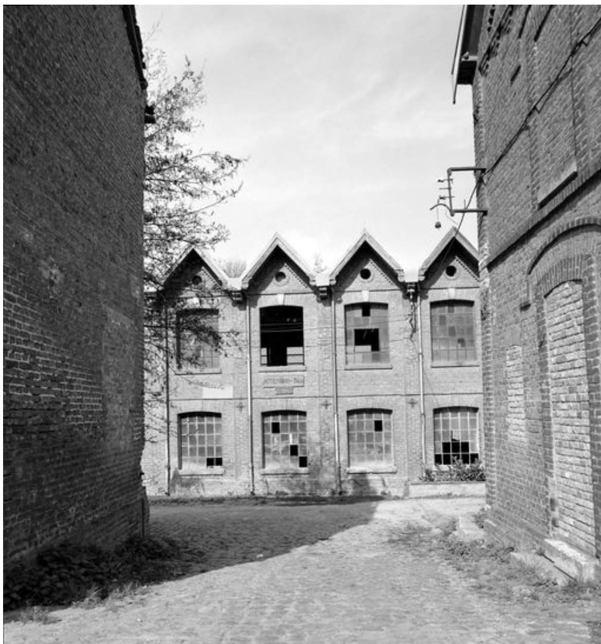
Ateliers de fabrication, flanc est détail.
