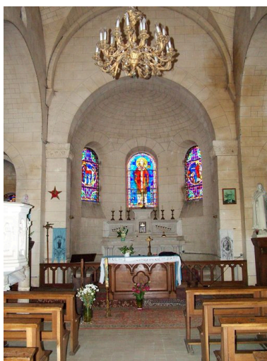
Vue du chœur. Phot. Inès Guérin IVR22_20030202383NUCA
