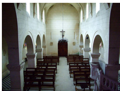
Vue générale intérieure. Phot. Inès Guérin IVR22_20030202382NUCA
