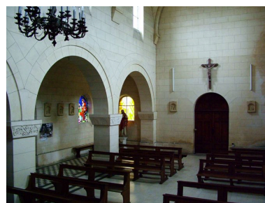
Vue de la nef et du bas-côté sud. Phot. Inès Guérin IVR22_20030202384NUCA
