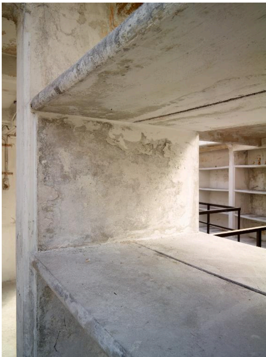
Bâtiment du dépôt, troisième étage : détail d'un rayonnage en béton armé. Chaque plateforme horizontale repose sur deux supports verticaux, eux-mêmes posés le long des piliers de béton.
