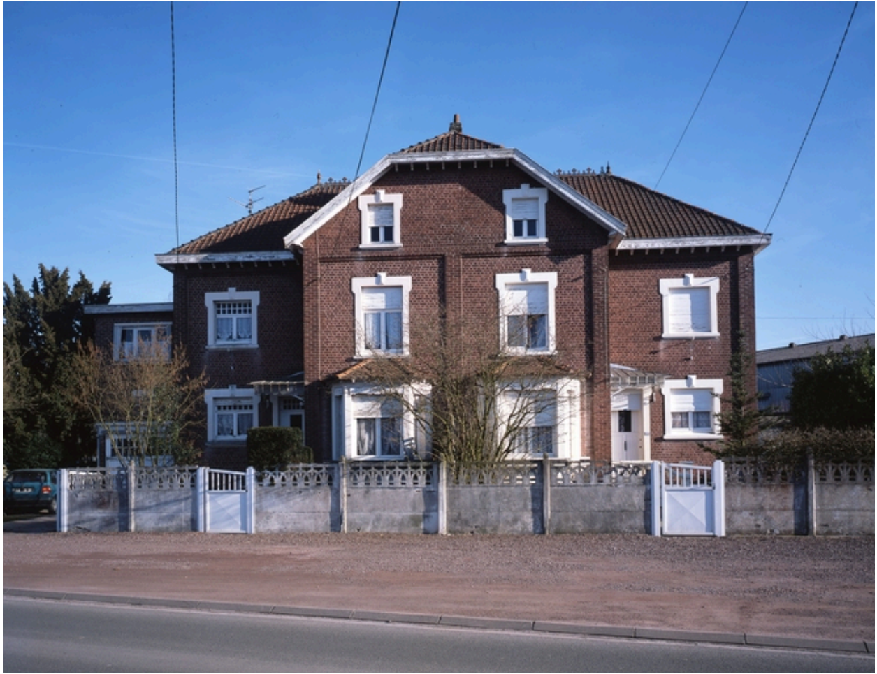
Vue générale des maisons d'ingénieur.
