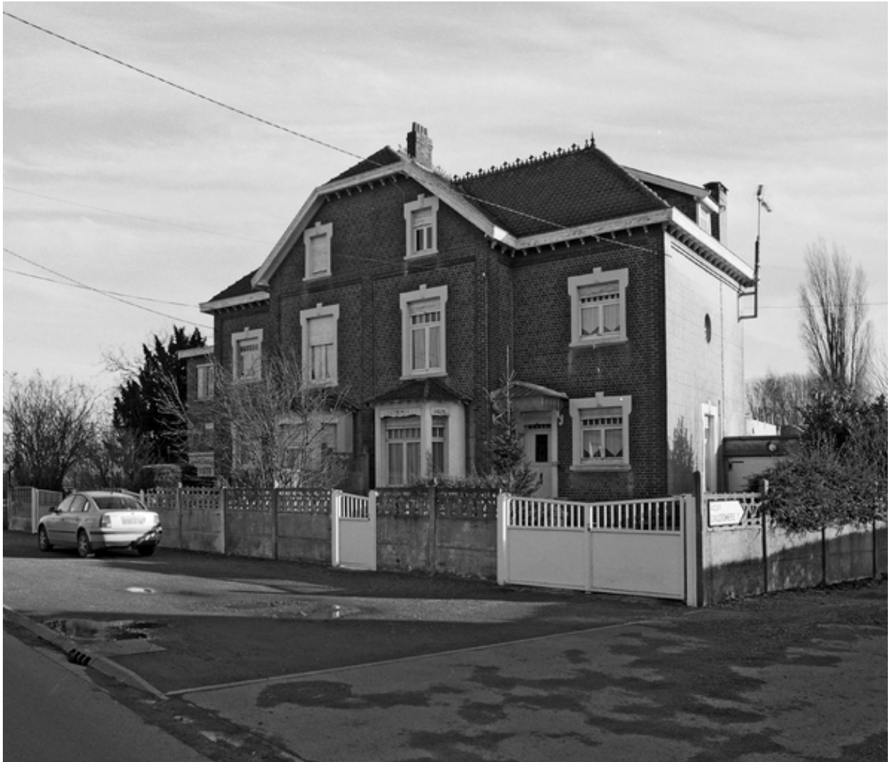
Vue générale des maisons d'ingénieur.
