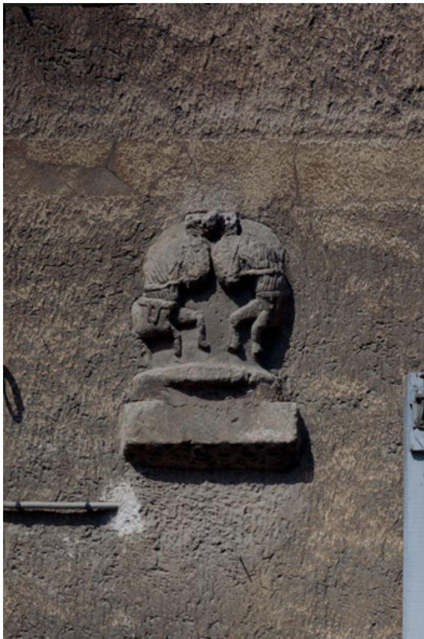
Chapiteau engagé dans la façade de la maison 18-20 rue du Faubourg de La Barre.
