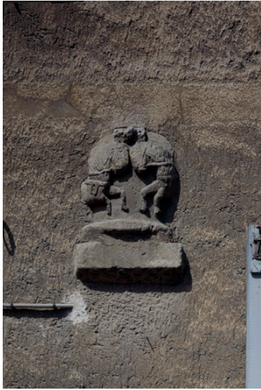
Chapiteau engagé dans la façade de la maison 18-20 rue du Faubourg de La Barre. Phot. Thierry Lefébure IVR22_19930200960XA
