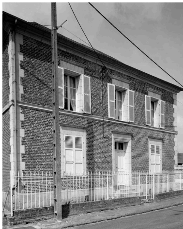
Elévation antérieure. Phot. Jean-Michel Perrin IVR22_19856000877X
