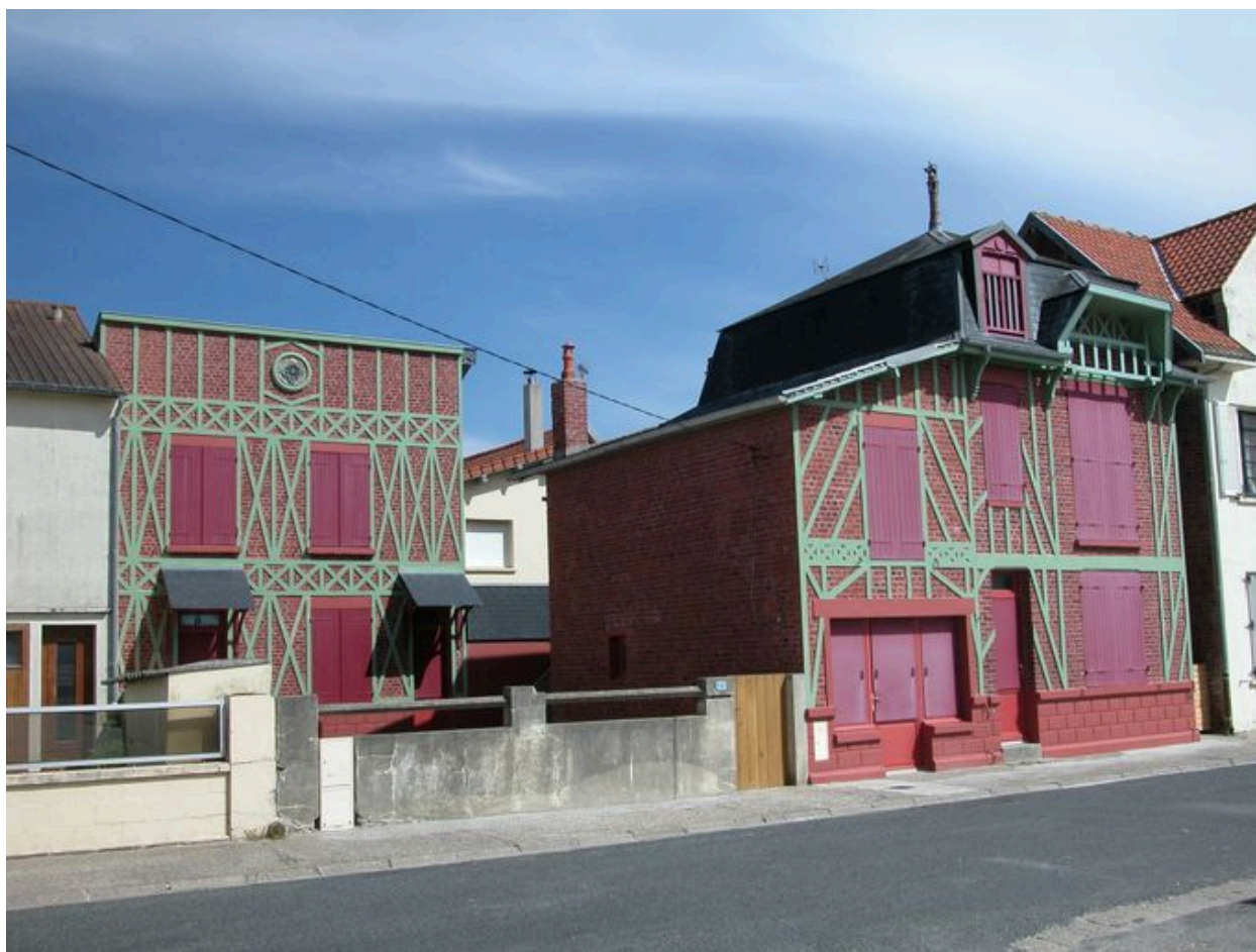
Vue d'ensemble des deux habitations, après restauration.
