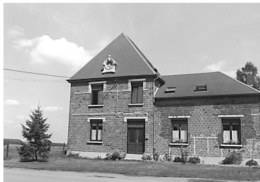
Ecole communale, rue du Moulin-Housseau : vue générale. Phot. Xavier-Philippe Guiochon IVR22_19980202679Z
