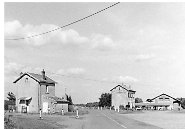
Ancienne gare : vue générale des bâtiments. Phot. Xavier-Philippe Guiochon IVR22_19980202687Z
