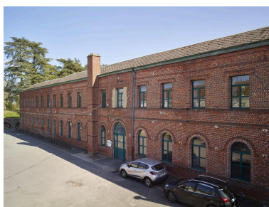
Façade sur l'ancienne cour du collège du bâtiment construit en 1850 par Casimir Pétaux (actuellement école primaire Chevray). Vue générale orientée sud-ouest/nord-est. Phot. Pierre Thibaut IVR32_20255900159NUCA
