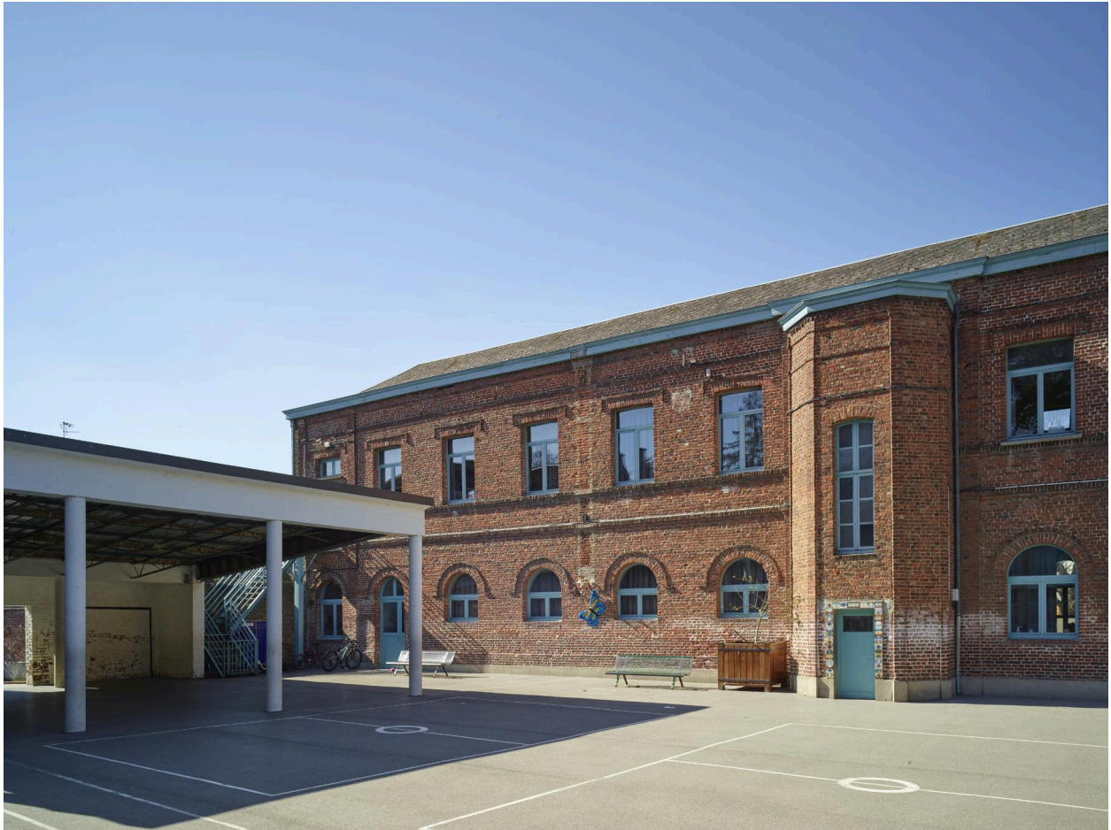
Façade arrière sur l'actuelle cour de l'école primaire du bâtiment construit en 1850 par Casimir Pétioux. Détail de la partie sud-ouest. Vue orientée sud-est/nord-ouest.
