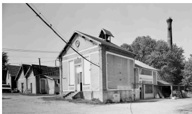
Chaufferie : élévation antérieure. Phot. Patrick Glotain IVR22_19936000710V
