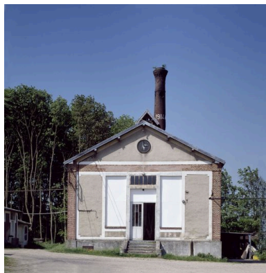
Chaufferie : élévation antérieure. Phot. Patrick Glotain IVR22_19936001826XA
