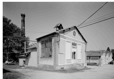
La chaufferie avec sa cheminée et les ateliers en shed à l'arrière plan. Phot. Patrick Glotain IVR22_19936000713V
