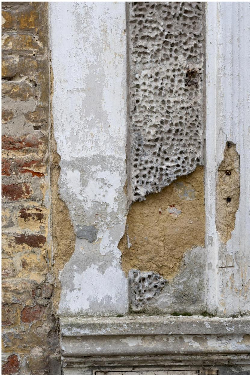
Enduit nid d'abeille : détail de la mise en place de l'enduit : les briques sur lesquelles il est posé apparaissent dans les manques (maison, 5, rue des Lombards).
