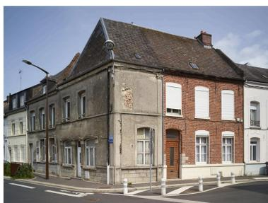
Maison, 2 rue de la Nouvelle-Zélande et façade sur la rue Georges V : façade entièrement enduite en nid d'abeille et brique posée en appareil picard, visible là où l'enduit est manquant.
