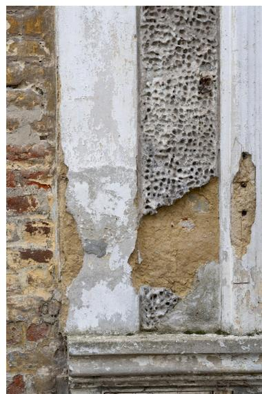
Enduit nid d'abeille : détail de la mise en place de l'enduit : les briques sur lesquelles il est posé
