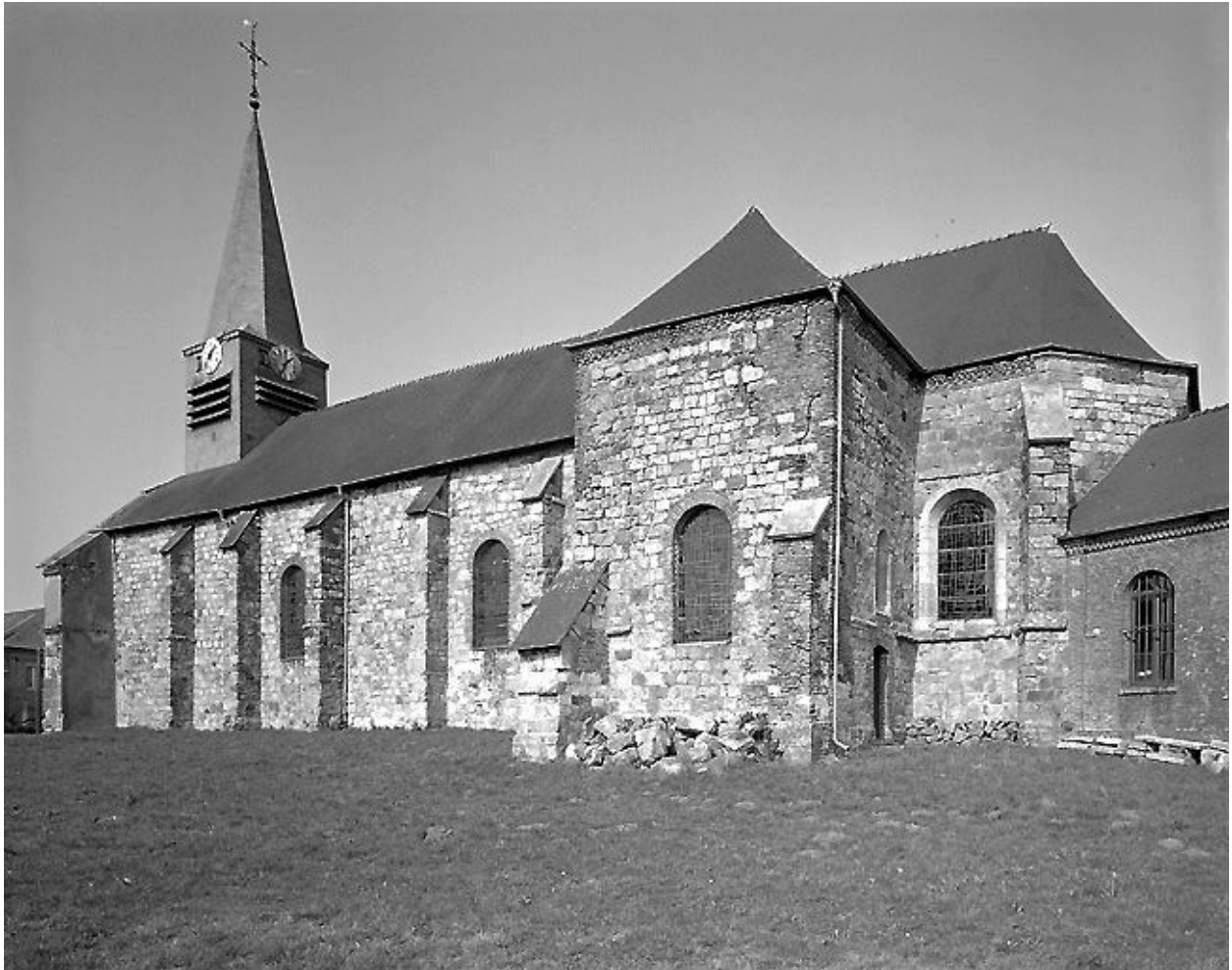
Vue depuis le sud-est du chevet et de l'élévation sud de la nef.
