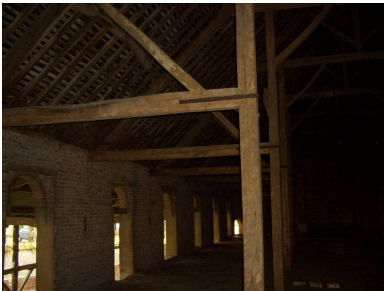
Vue des ouvertures donnant accès au grenier.
