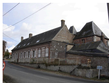
Vue du logis sur rue.
