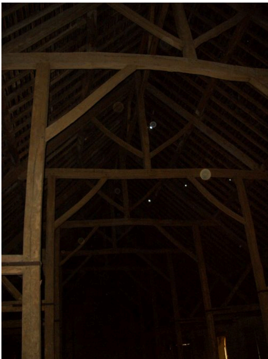
Vue partielle de la charpente des bouveries.
